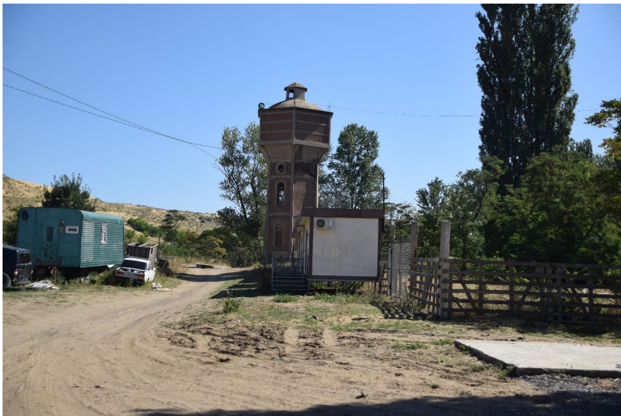
Фото 1. Общий вид на исследуемый объект с северо-восточной стороны от здания бывшего железнодорожного вокзала.
