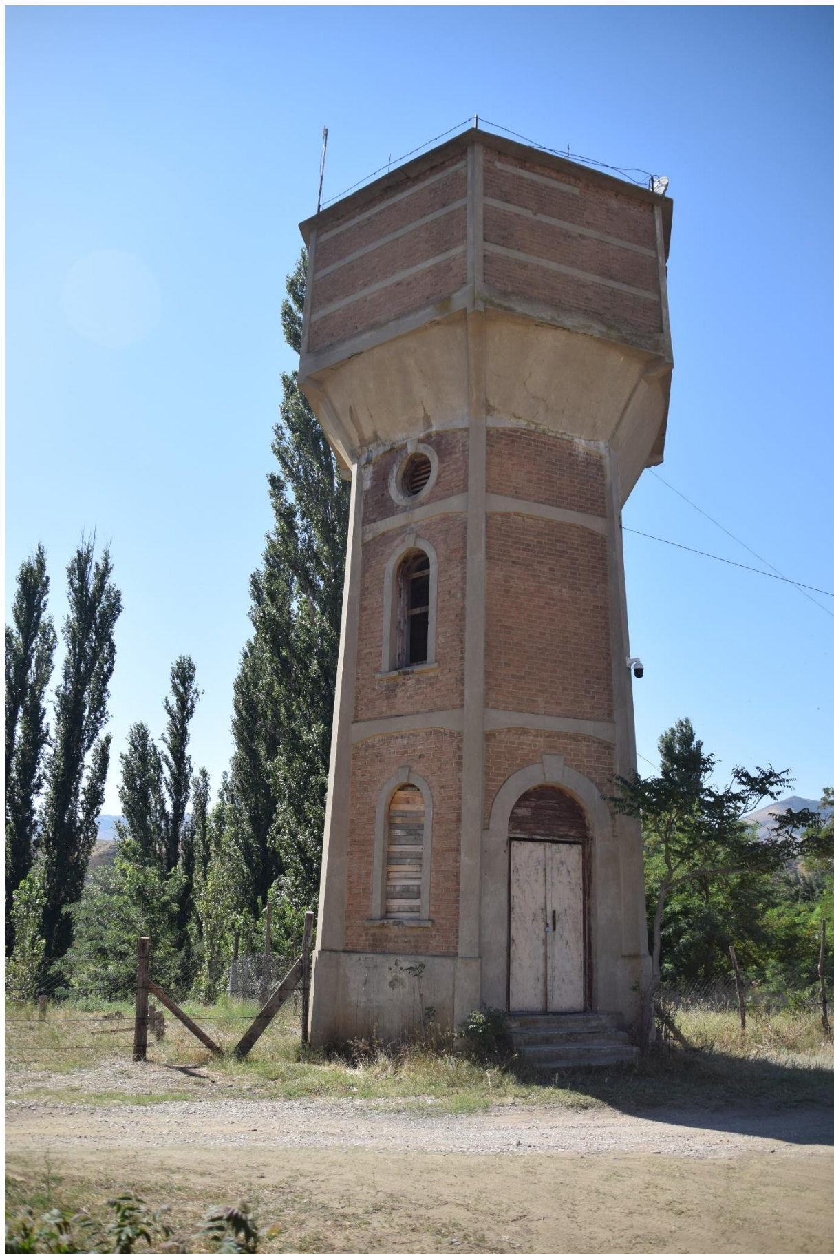
Фото 4. Вид на водонапорную башню и вход с северо-западной стороны.
