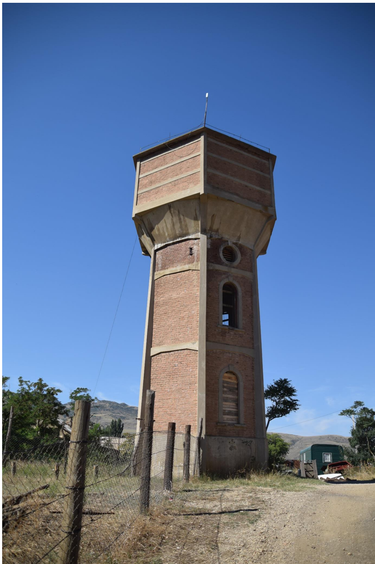
Фото 5. Общий вид водонапорной башни с северной стороны.
