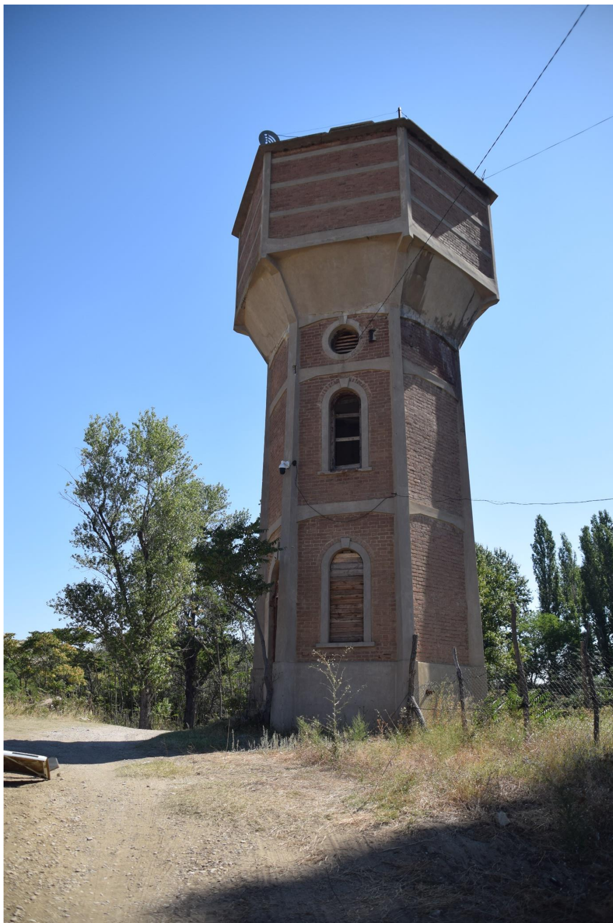
Фото 3. Вид на водонапорную башню с юго-западной стороны.
