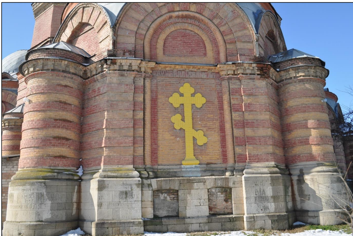
Фото 11. Общий вид здания, восточный фасад.
