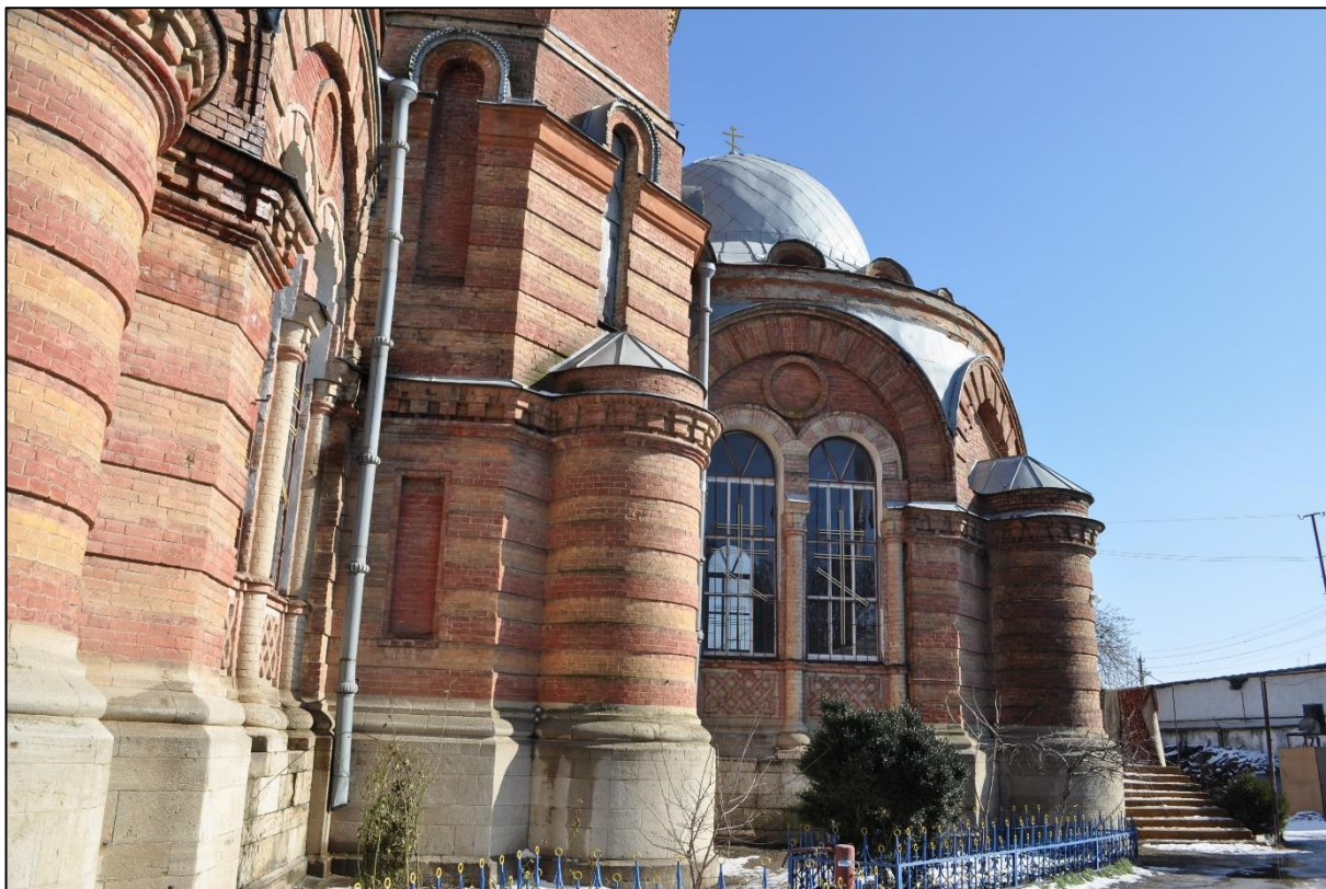
Фото 5. Общий вид здания, юго-западный фасад.
