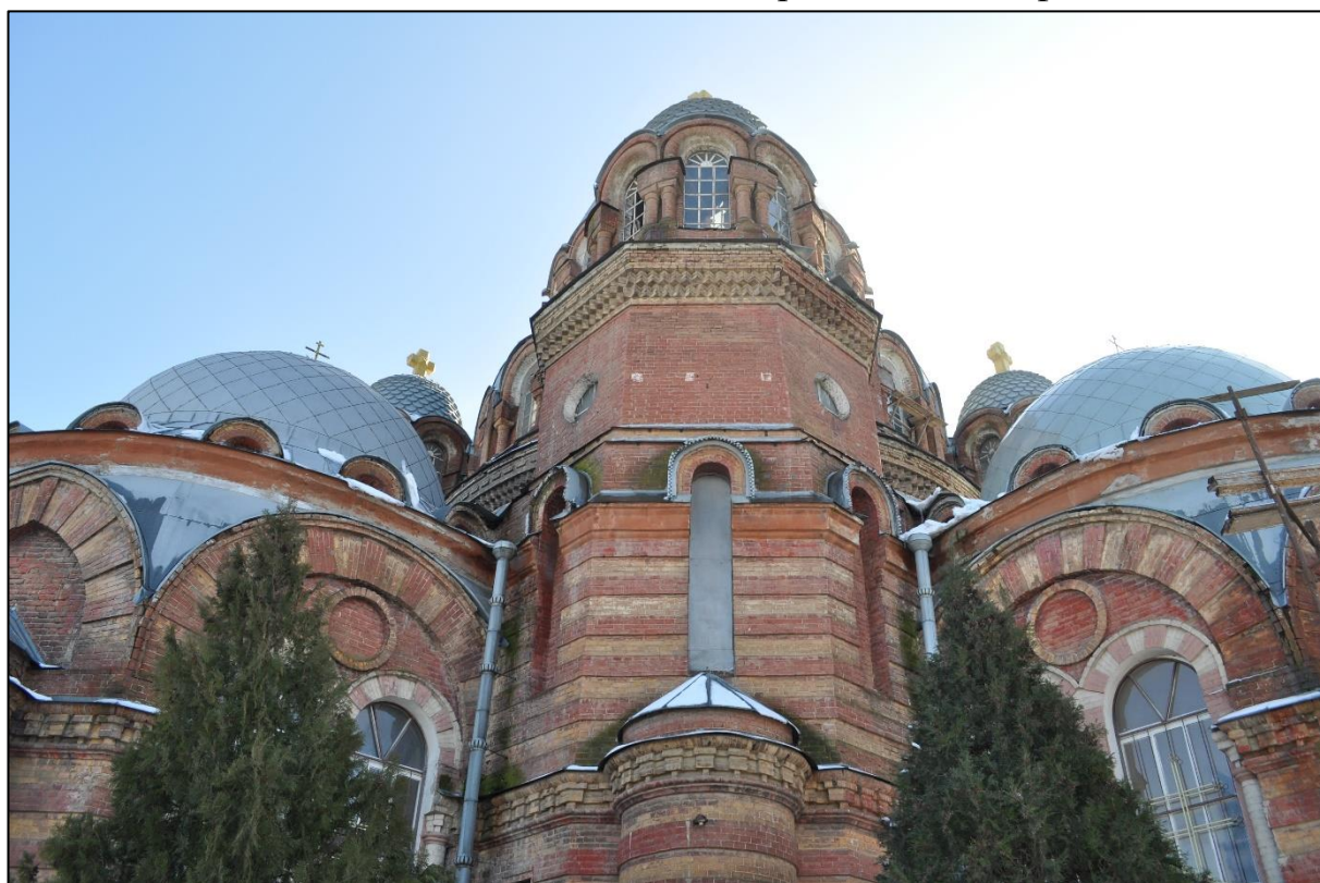
Фото 15. Общий вид здания, северо-восточный фасад.
