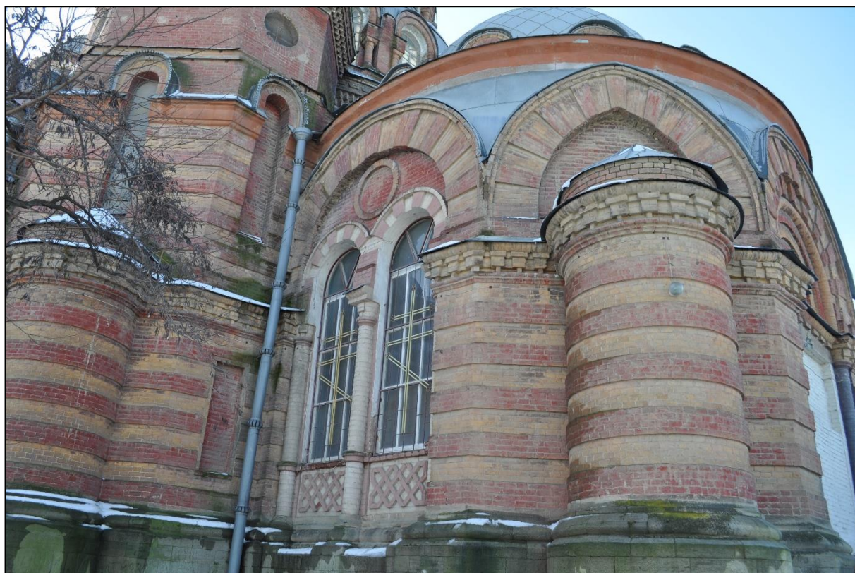
Фото 14. Общий вид здания, северо-восточный фасад.
