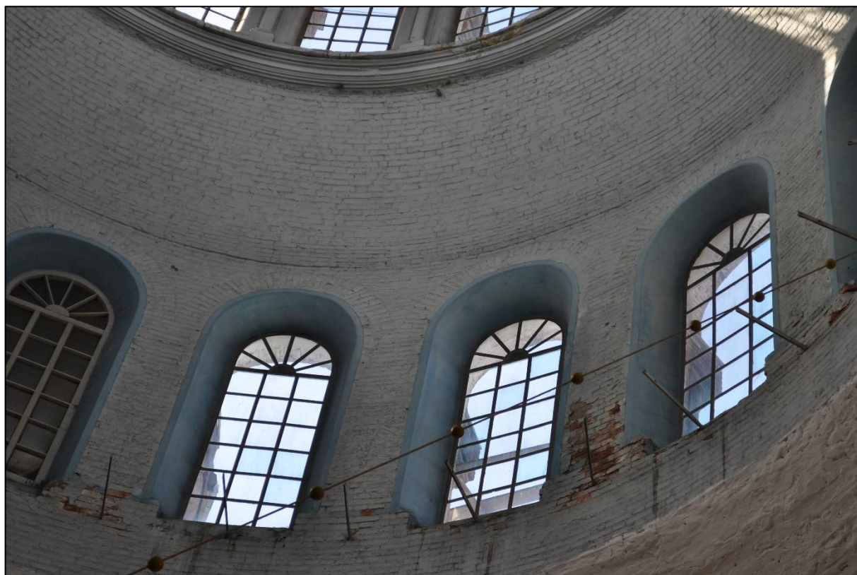
Фото 26. Общий вид интерьера объекта.
