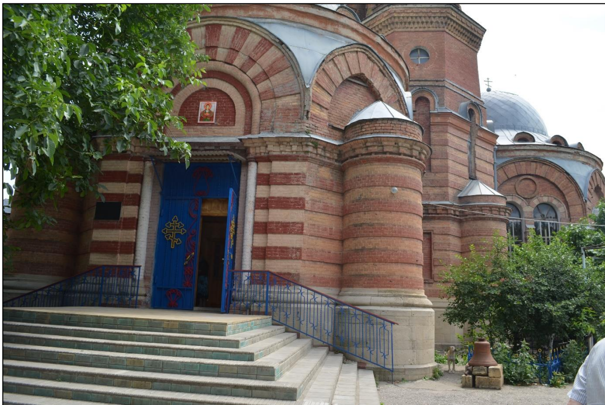
Фото 3. Общий вид здания, западный фасад.
