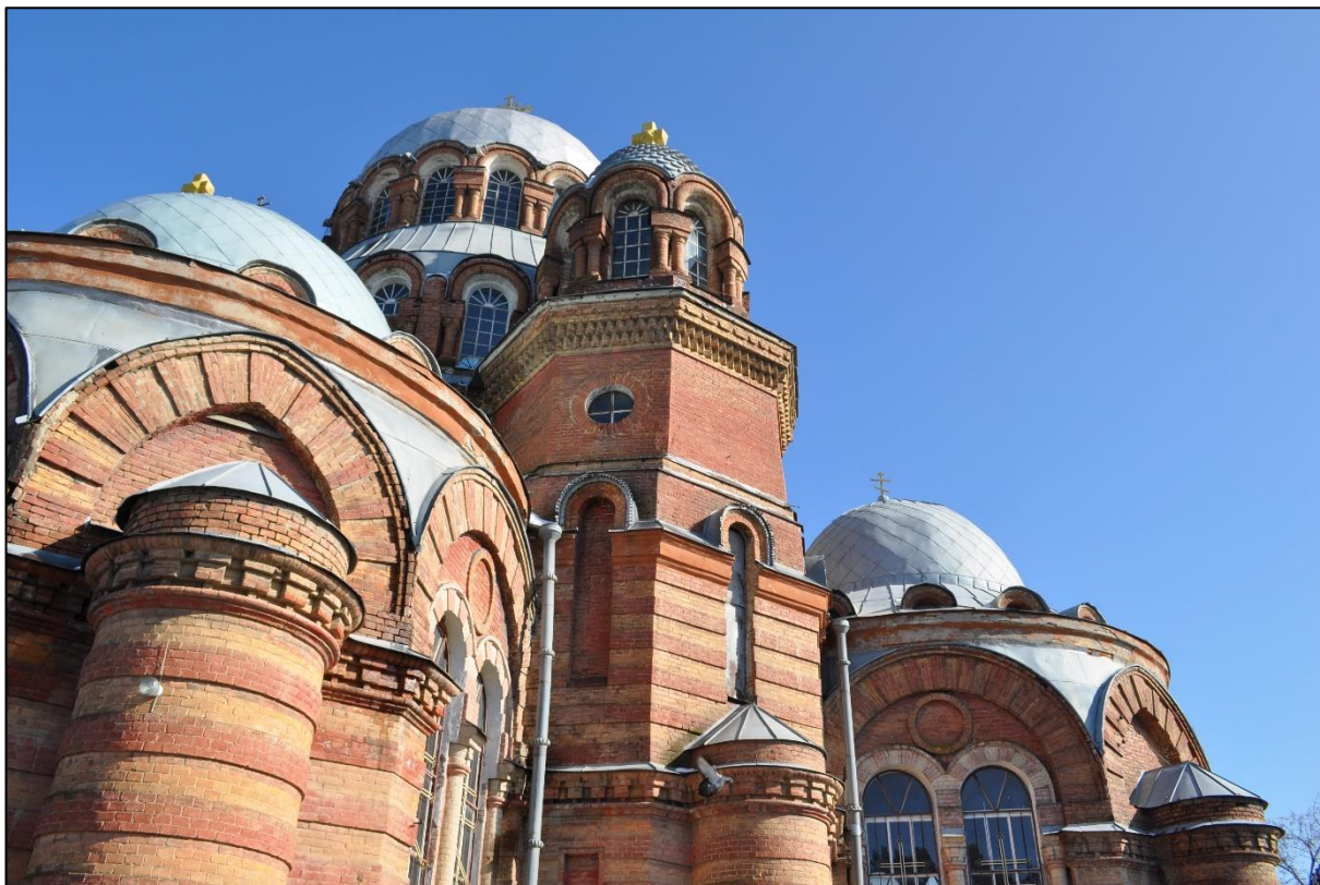
Фото 10. Общий вид здания, юго-восточный фасад.
