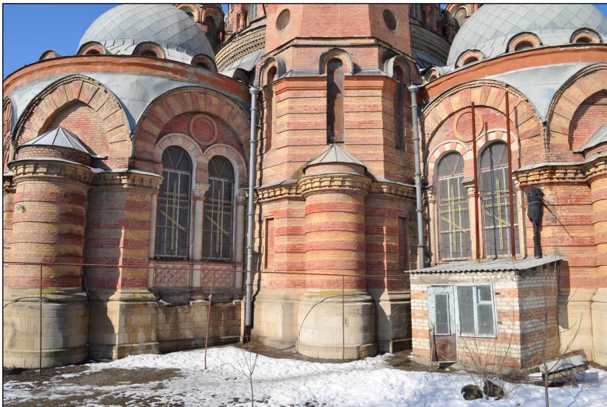
Фото 7. Общий вид здания, юго-восточный фасад.
