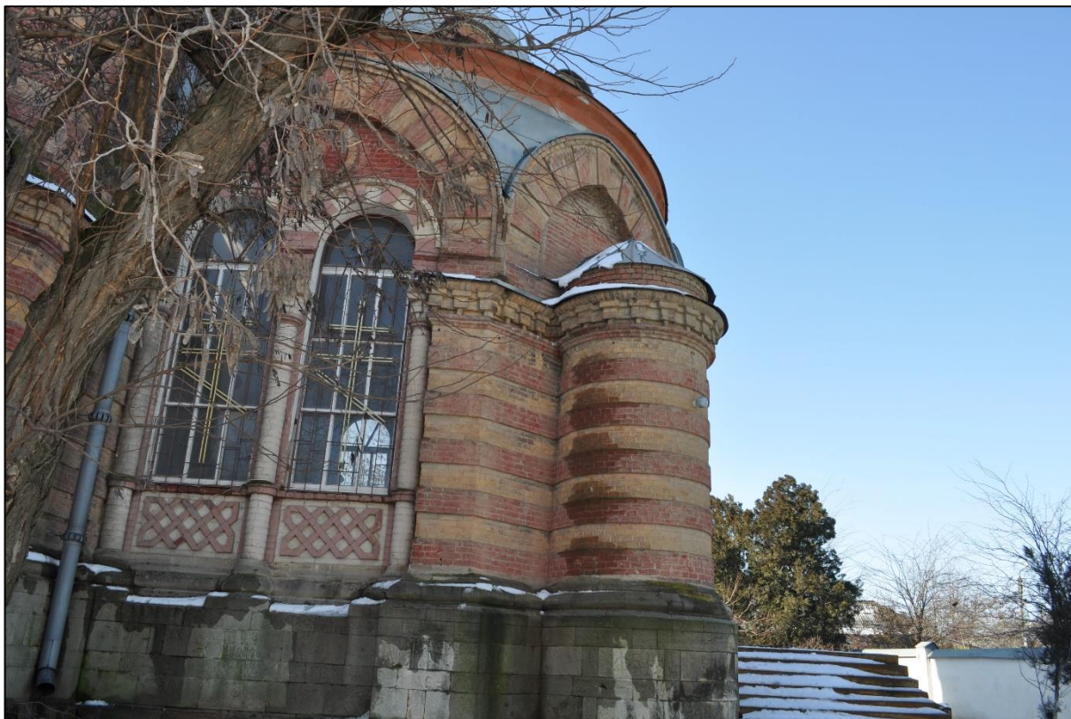
Фото 16. Общий вид здания, северо-восточный фасад.
