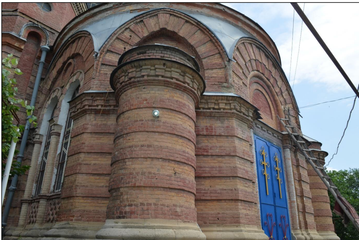
Фото 6. Общий вид здания, южный фасад.
