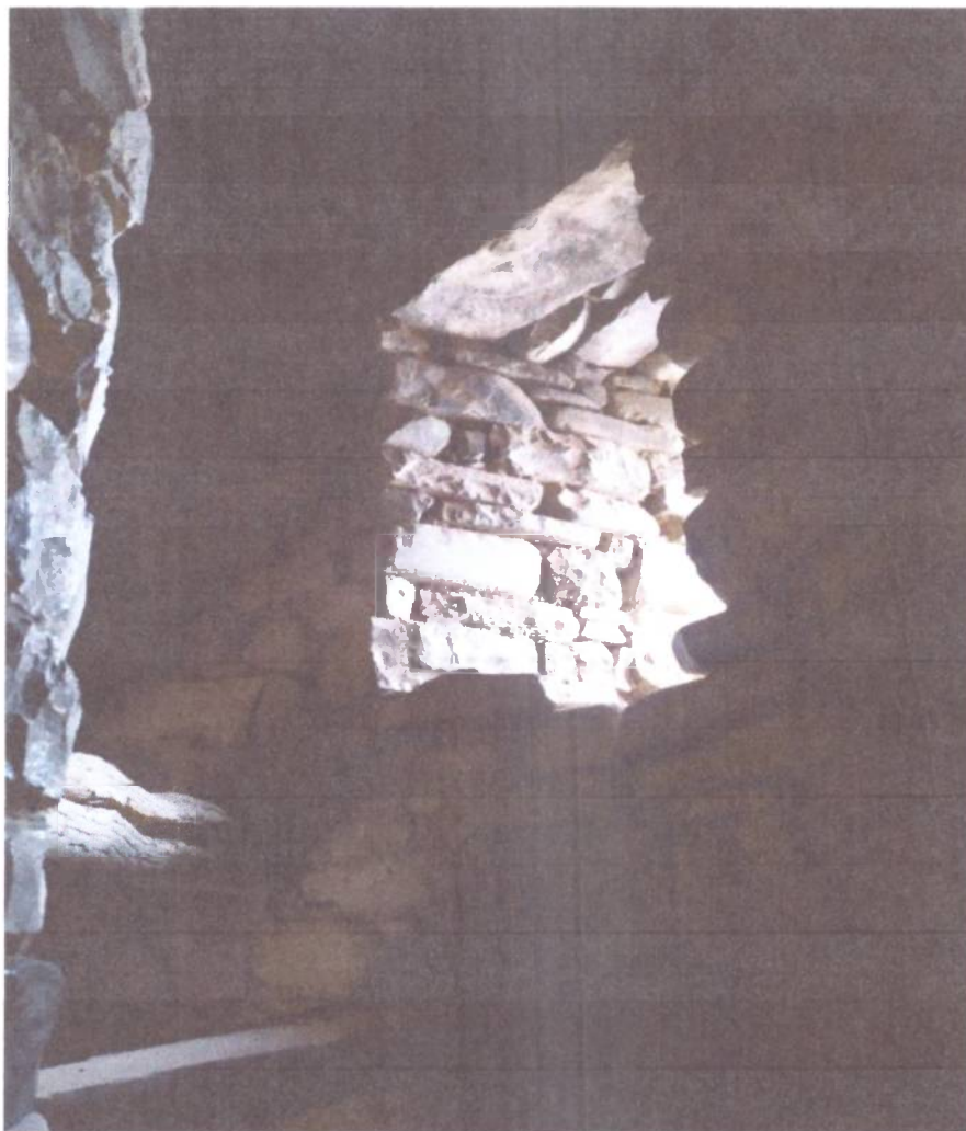
Проем в стене минарета. Вид изнутри башни
