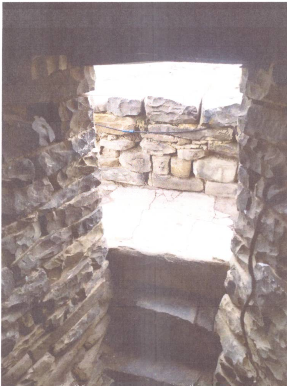
Проем выхода на верхнюю площадку минарета
