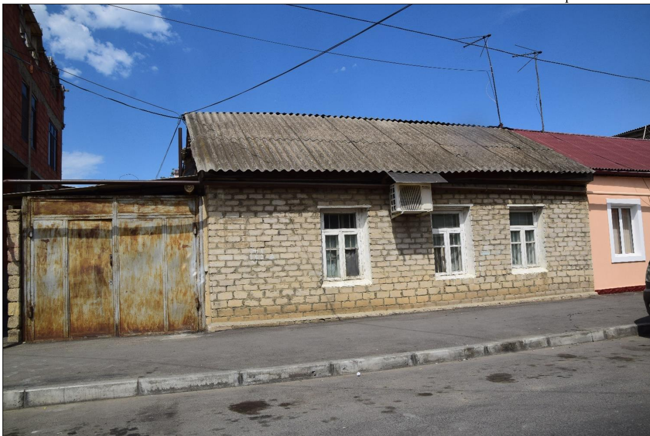
Т.ф. 25. Застройка по нечетной стороне улицы Малыгина. Фото: Гаджиев Р.И., июль 2020 г.
