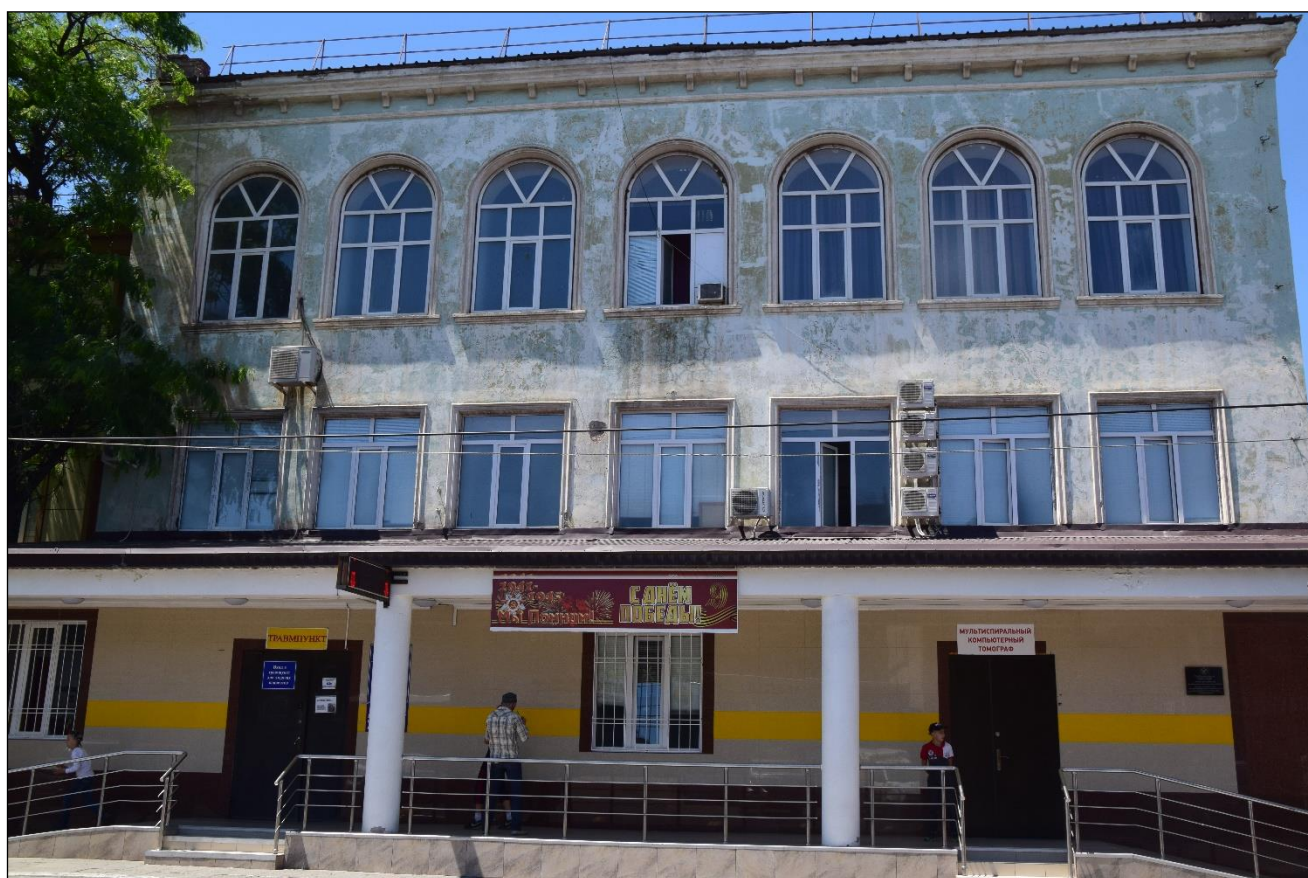
Т.ф. 2. Республика Дагестан, г. Махачкала, ул. Р.Гамзатова, д. 82. «Здание горбольницы №1, где размещался эвакуогоспиталь 5061». Юго-западный фасад объекта. Фото: Гаджиев Р.И., июль 2020 г.
