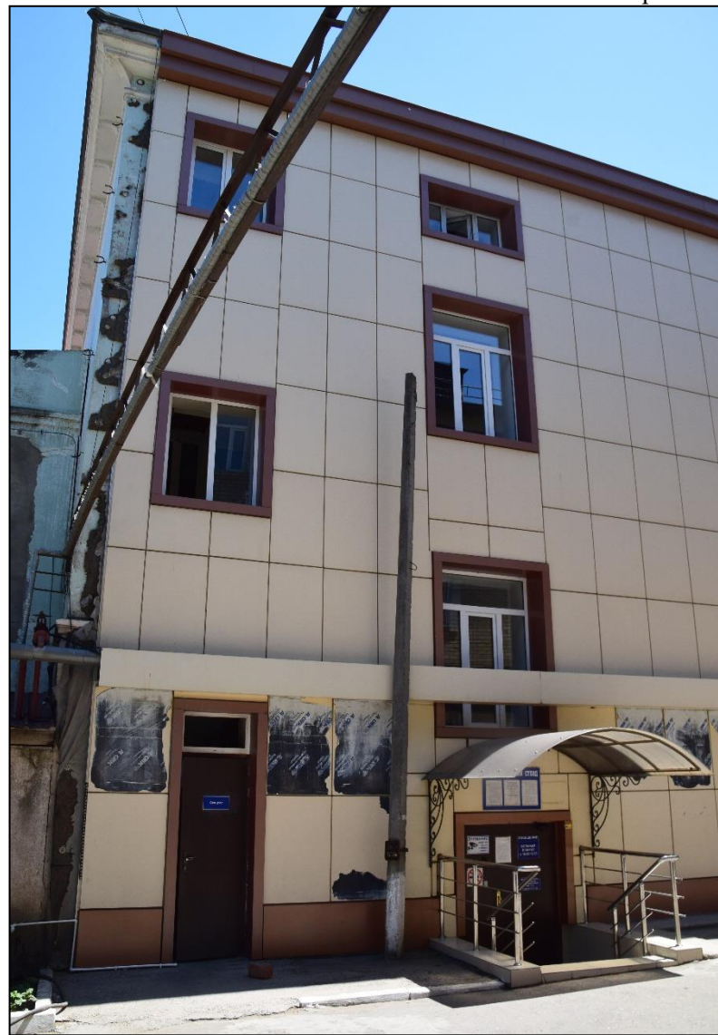
Т.ф. 6. Республика Дагестан, г. Махачкала, ул. Р.Гамзатова, д. 82. «Здание горбольницы №1, где размещался эвакуогоспиталь 5061». Дворовый (северо-восточный) фасад объекта. Фото: Гаджиев Р.И., июль 2020 г.
