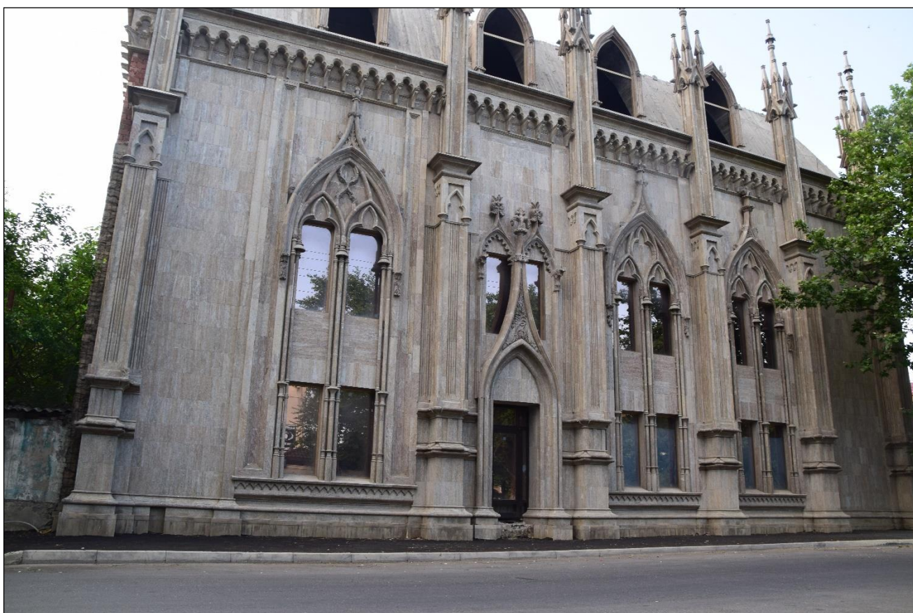
Т.ф. 18. Здание №115 по проспекту Расула Гамзатова. Вид с улицы Гамзата Цадасы. Фото: Гаджиев Р.И., июль 2020 г.
