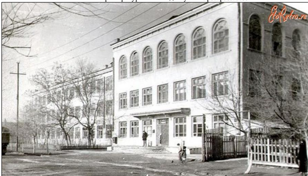
Главный (юго-восточный) фасад исследуемого объекта. Вид с пересечения нынешних проспекта Расула Гамзатова и улицы Гамзата Цадасы. Фото второй половины XX века.
