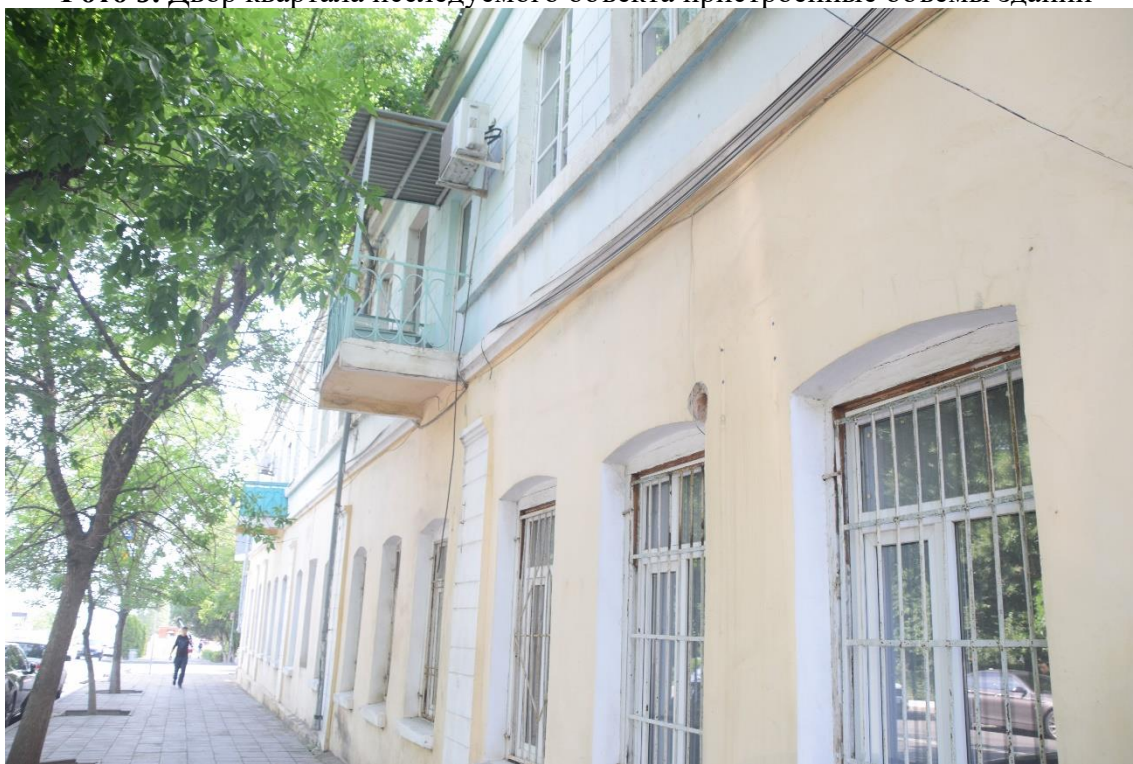
Фото 10. Фасад по ул. Леваневского, первый этаж, и балкон второго этажа
