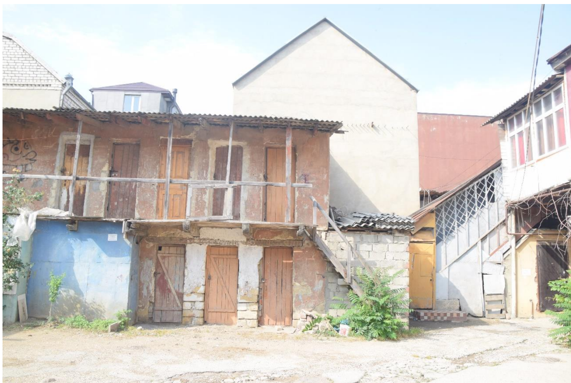
Фото 9. Двор квартала исследуемого объекта пристроенные объемы зданий
