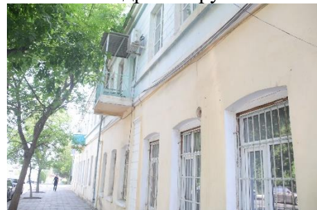
Балкон второго этажа
