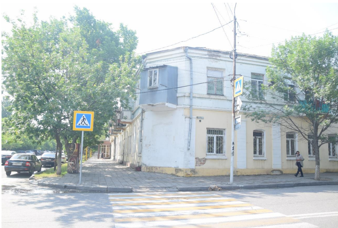
Фото 2. Угловой фасад исследуемого здания
