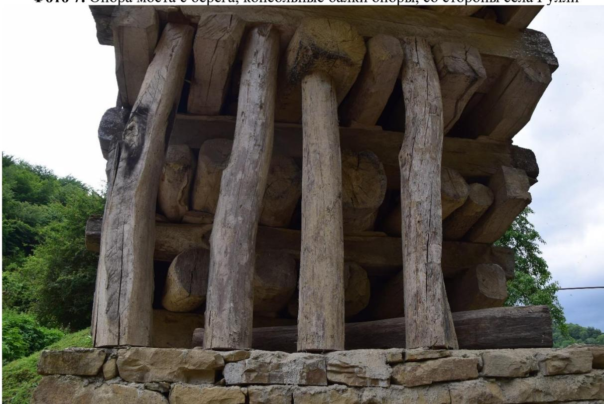
**Фото 8.** Подпорные балки, обеспечивающие стабильность мосту
