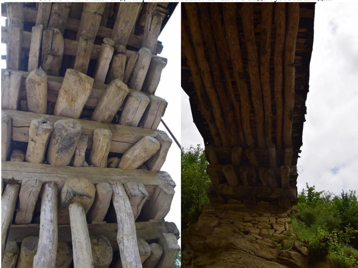
**Фото 10, 11.** Опоры моста с берега, консольные балки опоры, со стороны села Шиле
