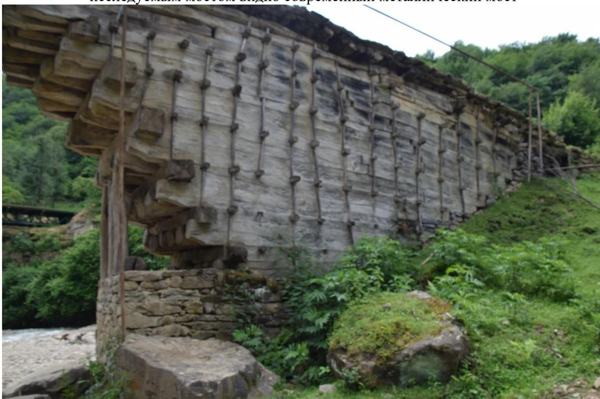
**Фото 4.** Вид на исследуемый объект с юго-западной стороны, стяжки бортов моста.
