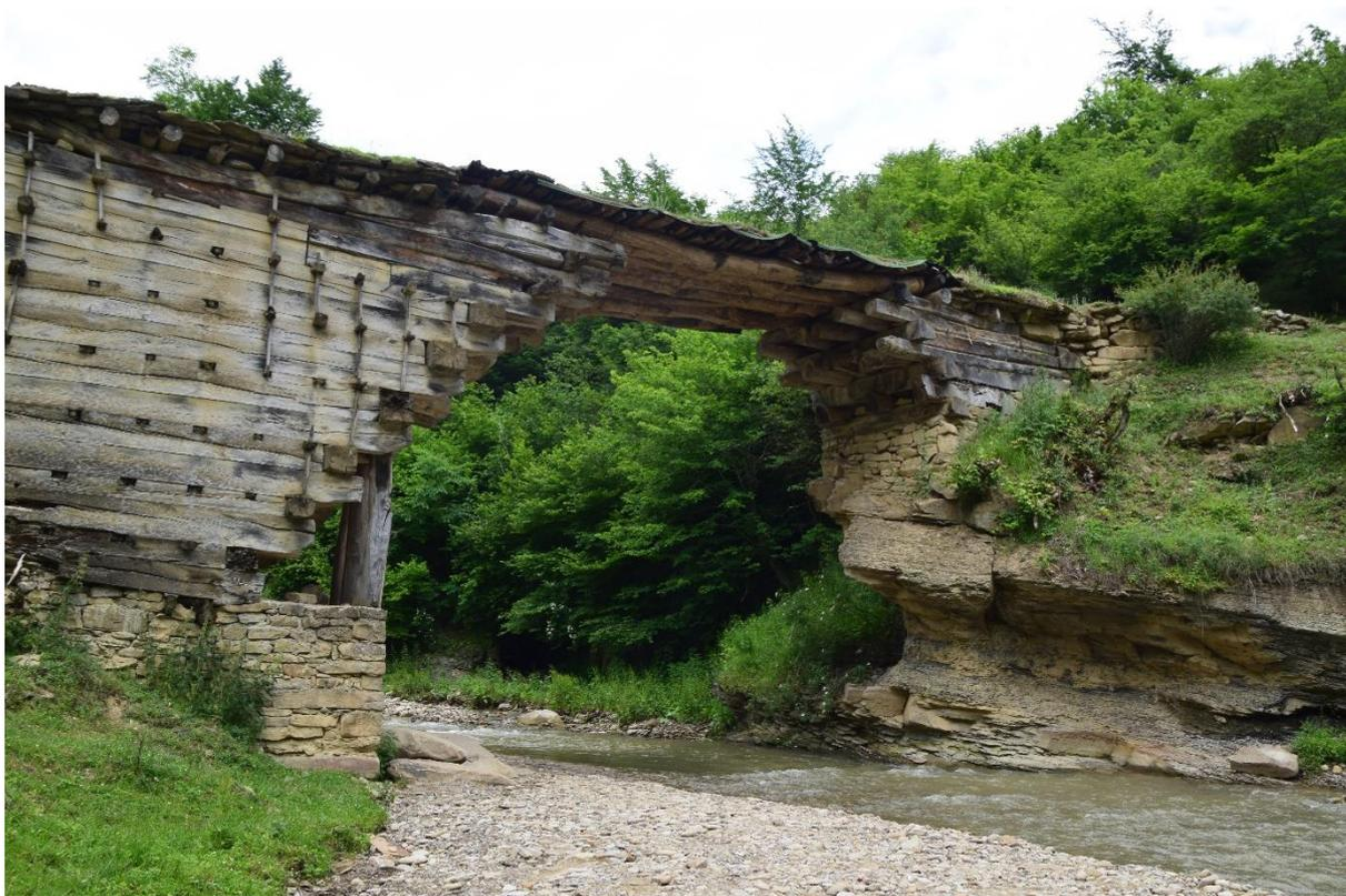
**Фото 14.** Вид на исследуемый объект с северо-восточной стороны, стяжки бортов моста, пролет.
