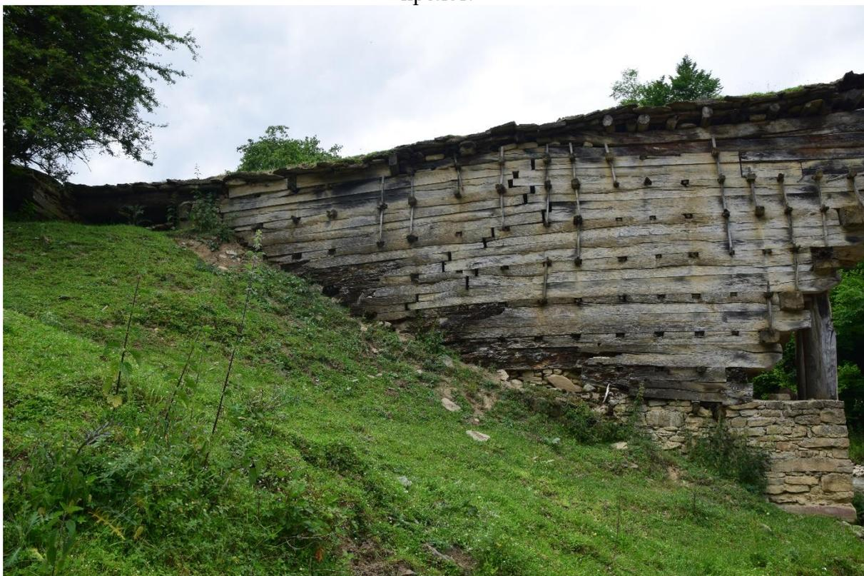
**Фото 15.** Вид на исследуемый объект с северо-восточной стороны, стяжки бортов моста, скат моста.
