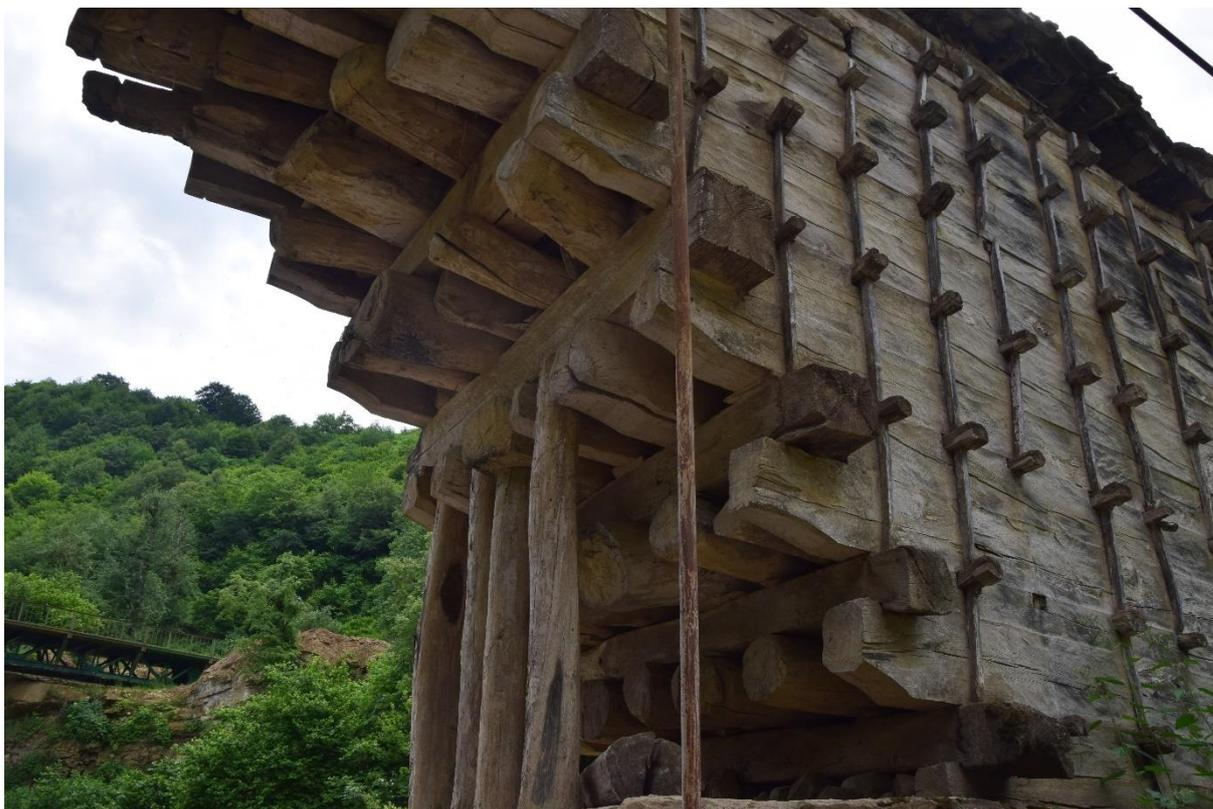
**Фото 7.** Опора моста с берега, консольные балки опоры, со стороны села Гулли
