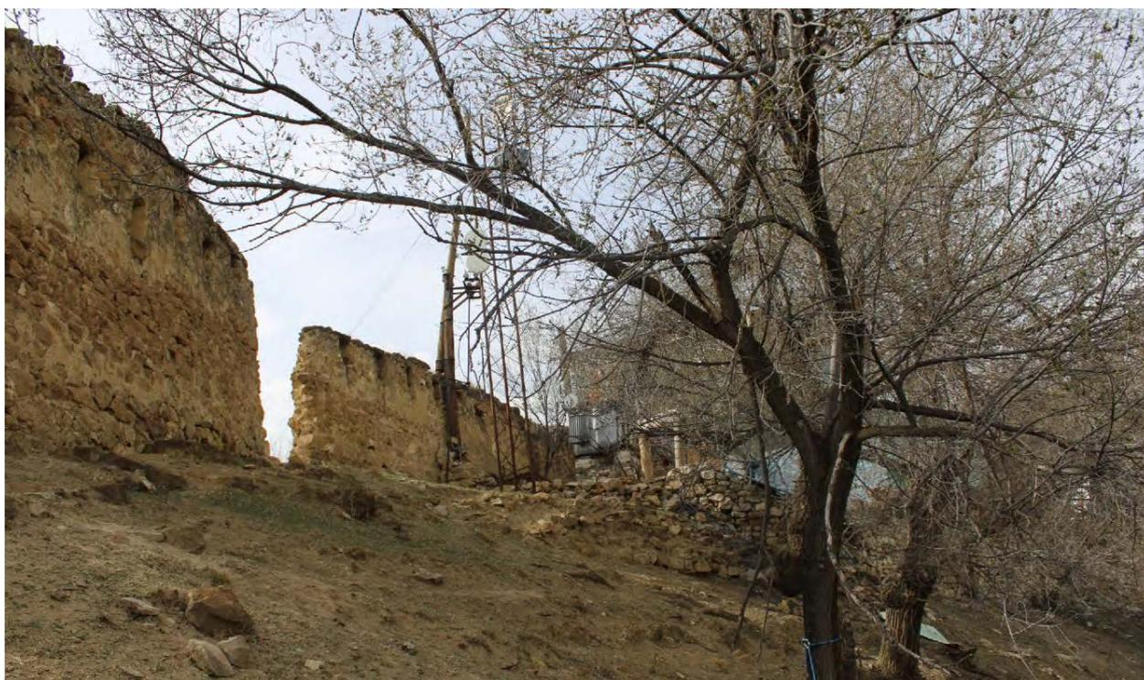
Фото 6. Внутренний фасад крепостной стены с проемом и разломами.
