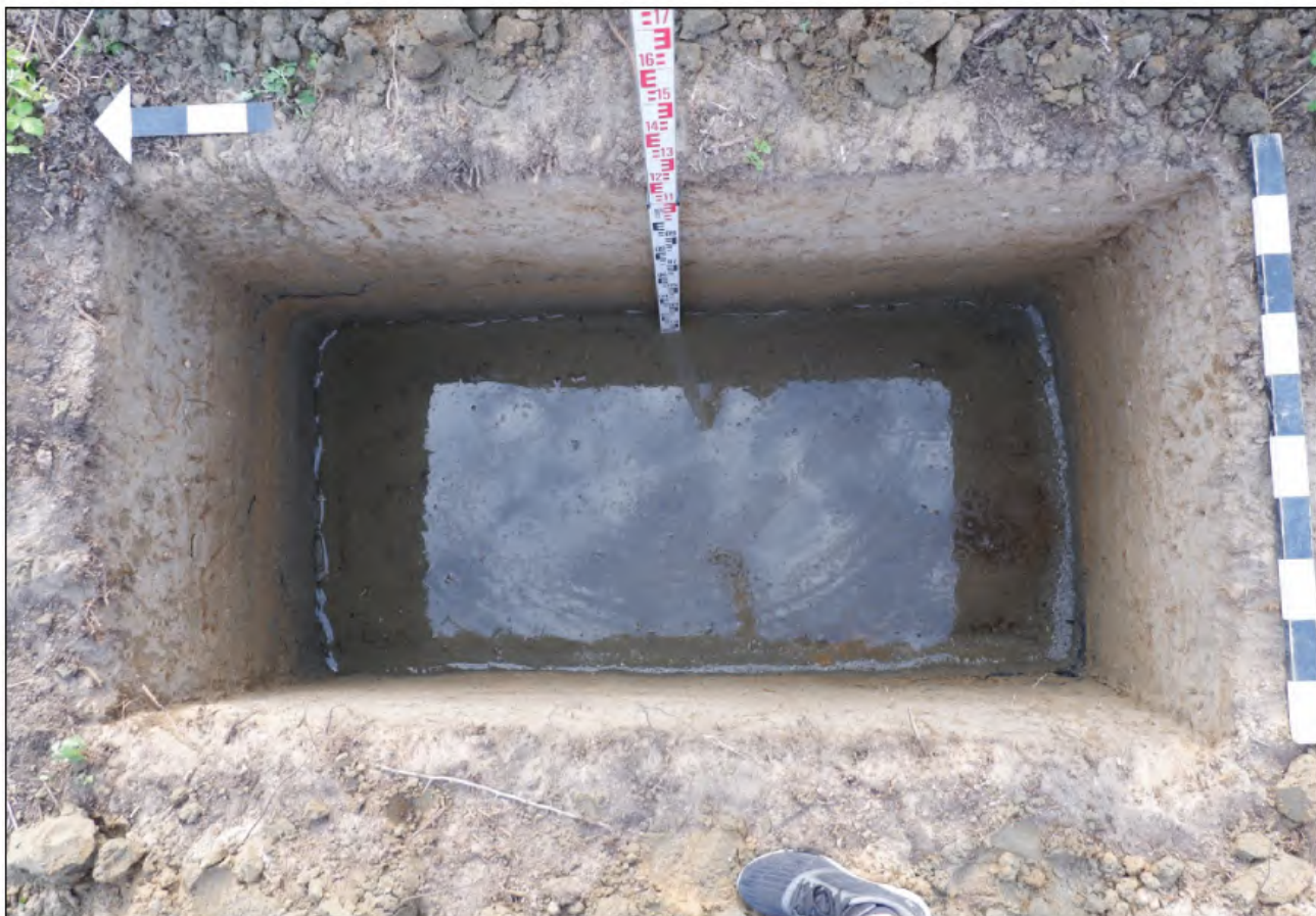
Илл. 31. Шурф 78 после окончания работ. Пласт 6. Вид с запада.
