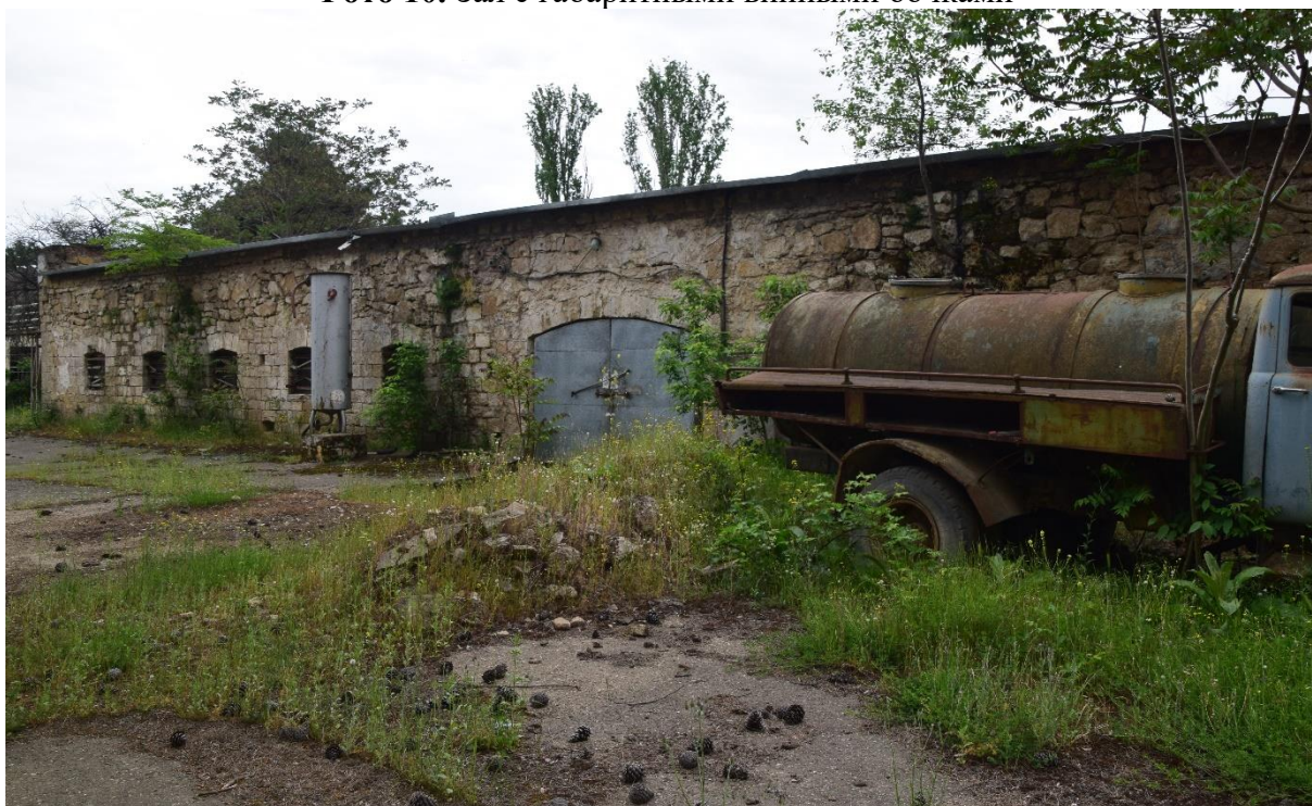
Фото 11. Наземные помещения технического характера (склады)
