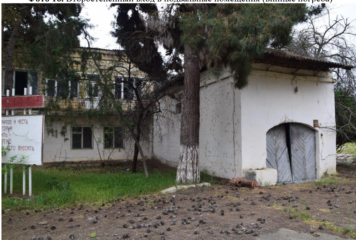
Фото 17. Второстепенный вход в подвальные помещения (винные погреба)
