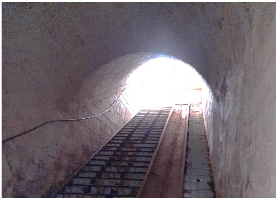
Фото 4. Спуск в подвал, лестница и рельса для скатывания бочек
