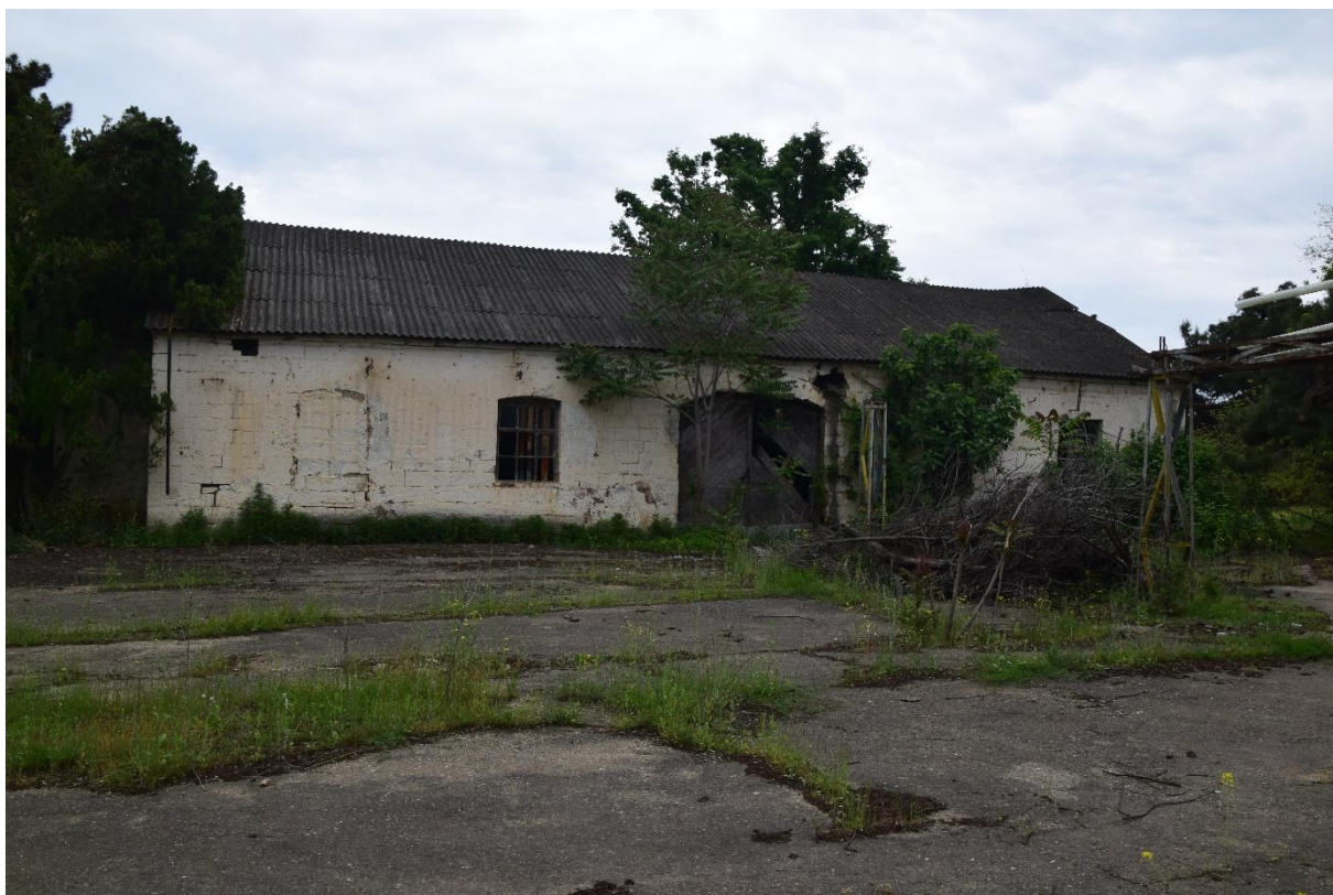
Фото 14. Наземные помещения технического либо складского характера
