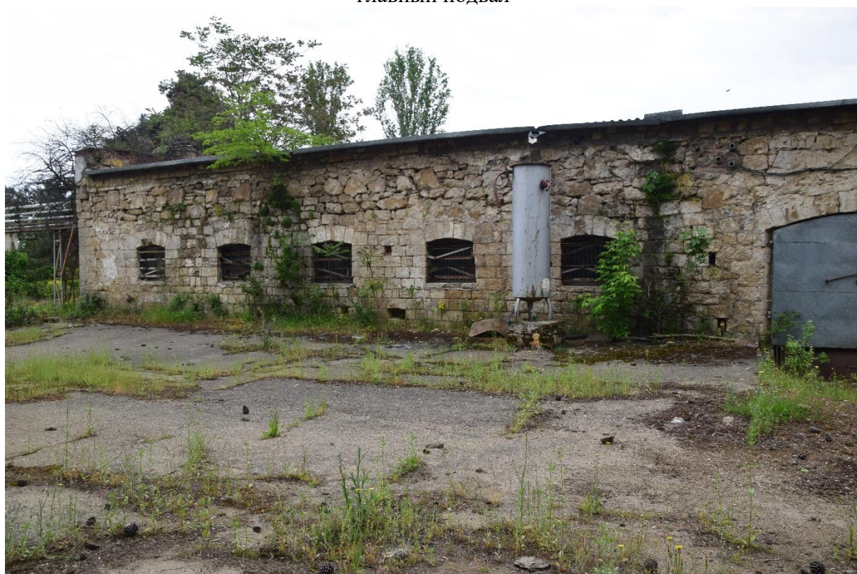
Фото 13. Наземные помещения технического характера (склады), окна помещения
