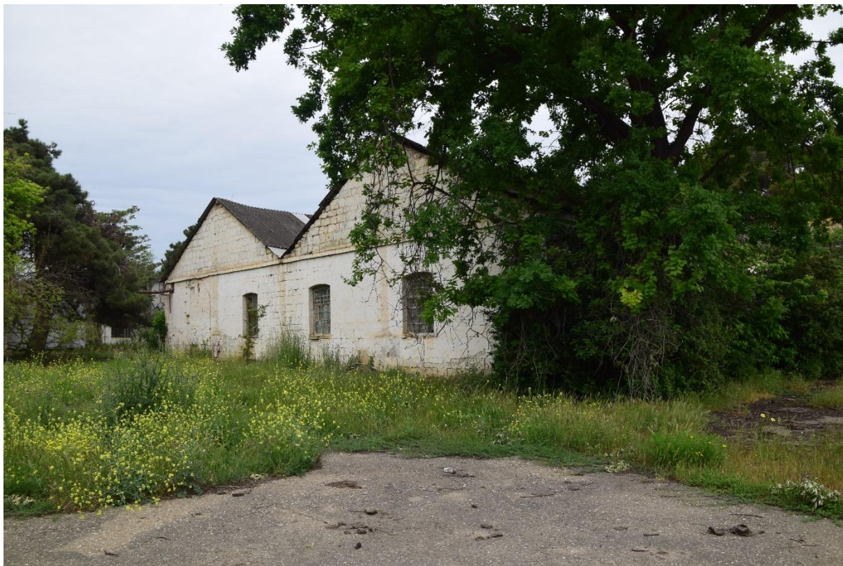
Фото 20. Наземные помещения технического либо складского характера
