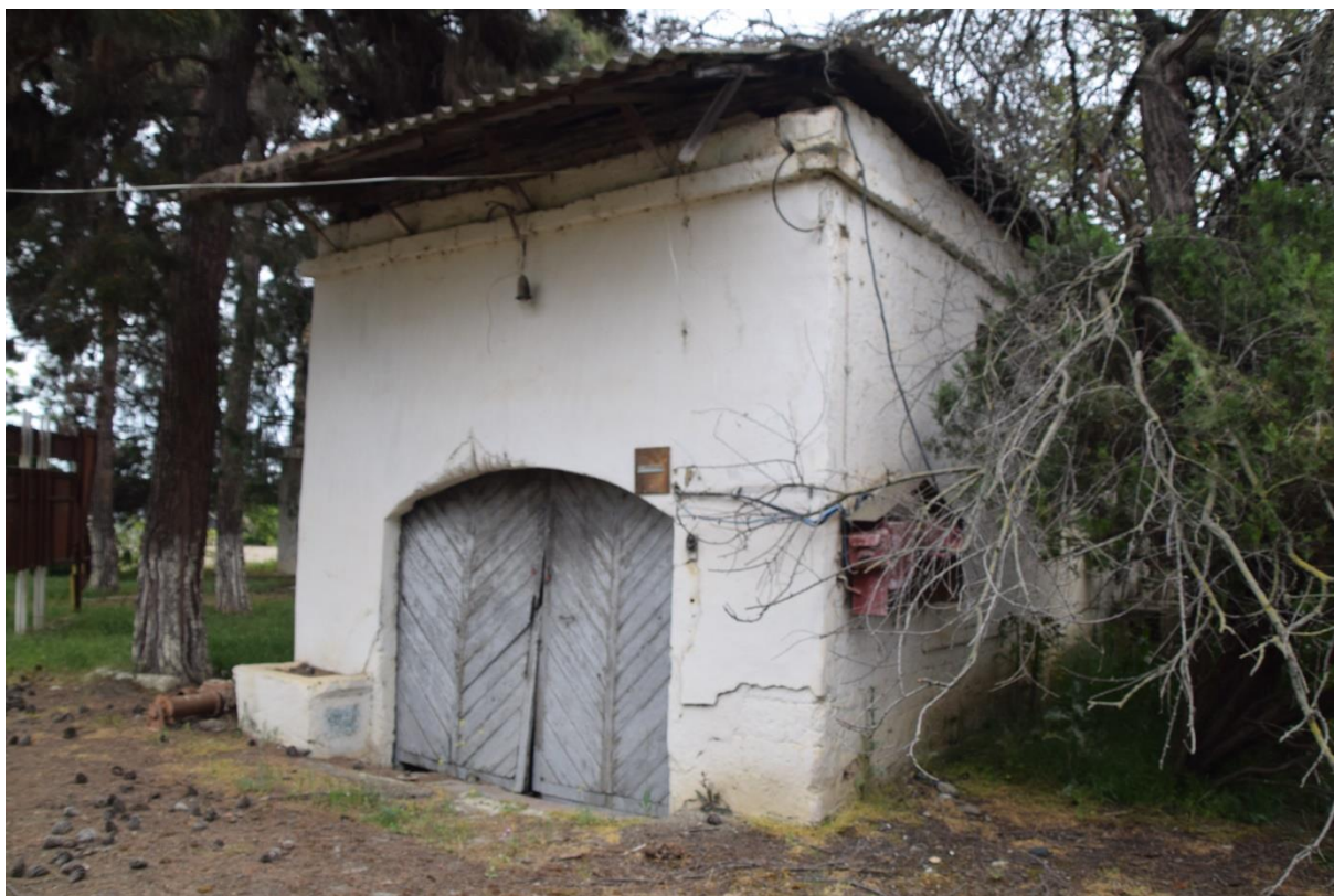
Фото 16. Второстепенный вход в подвальные помещения (винные погреба)
