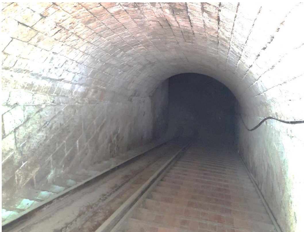
Фото 3. Спуск в подвал, лестница и рельса для скатывания бочек
