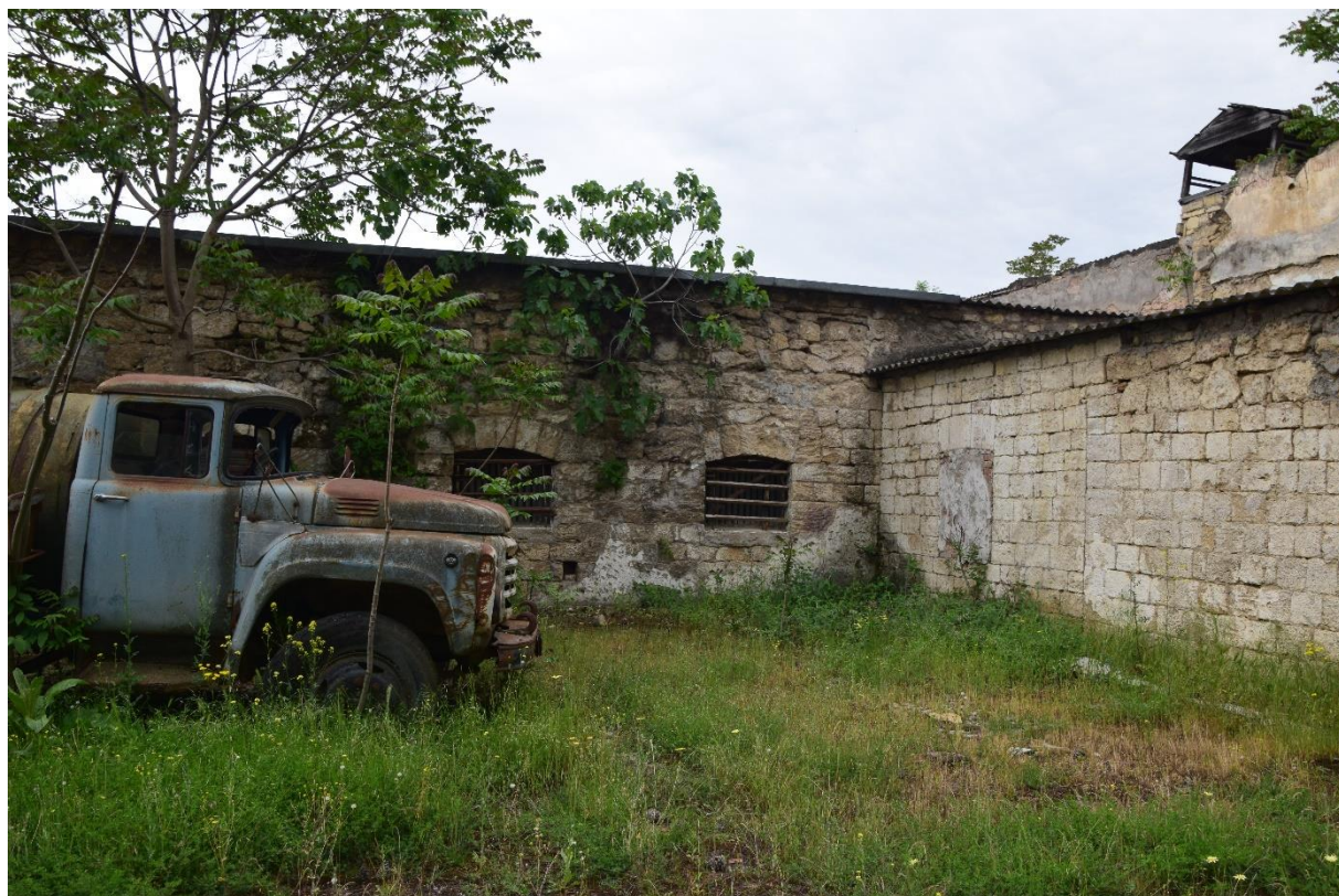
Фото 12. Наземные помещения технического характера (склады), справа виден вход в главный подвал
