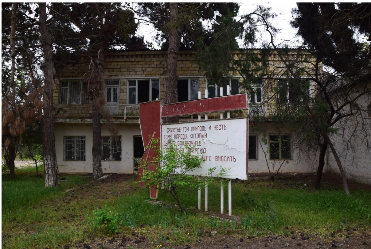
Фото 18. Вид на здание, выполняющее функцию административного здания на территории объекта
