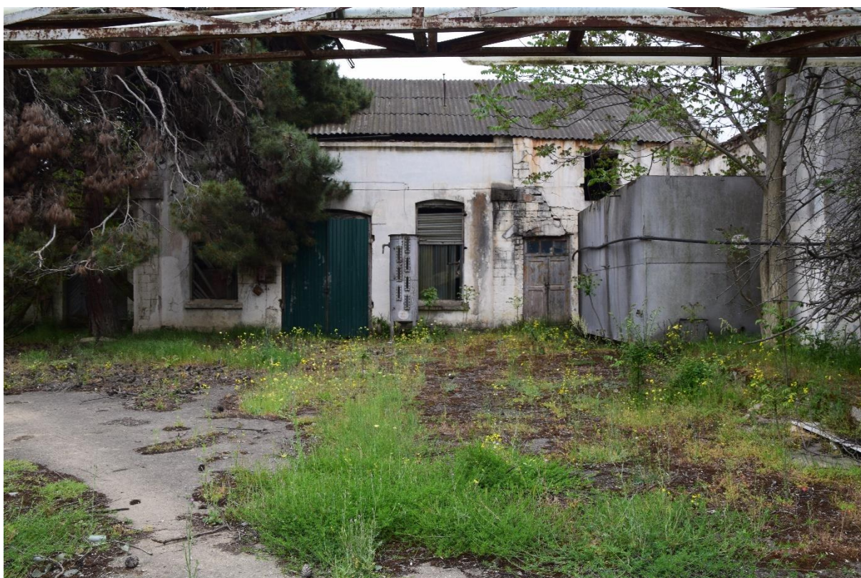
Фото 15. Наземные помещения технического либо складского характера
