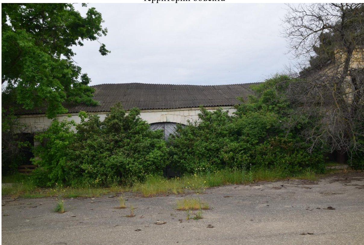
Фото 19. Наземные помещения технического либо складского характера
