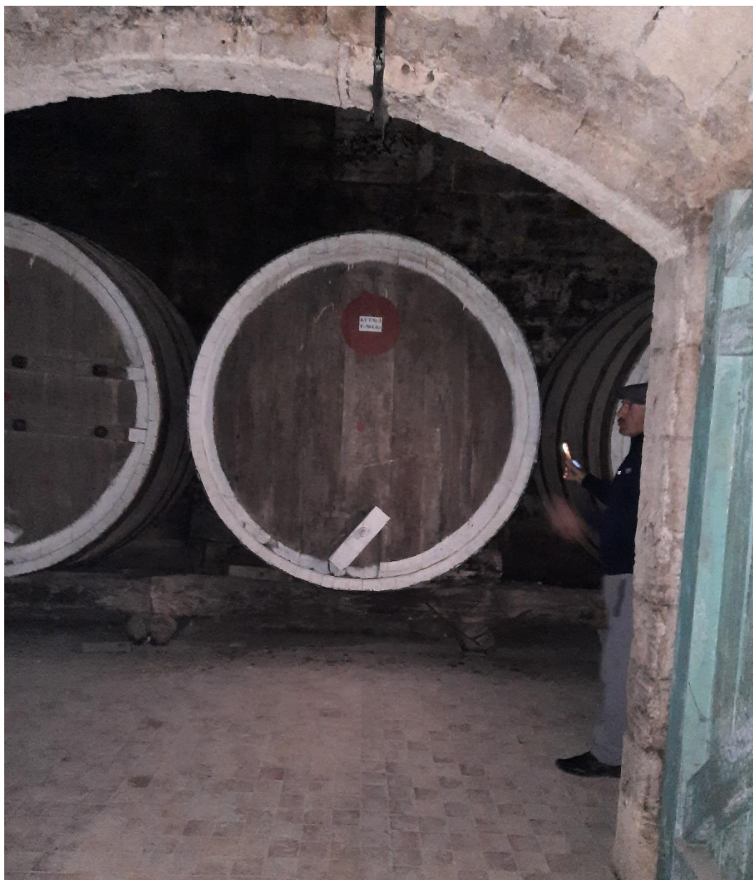
Фото 9. Арочный проем (дверной проем) в зал с габаритными бочками
