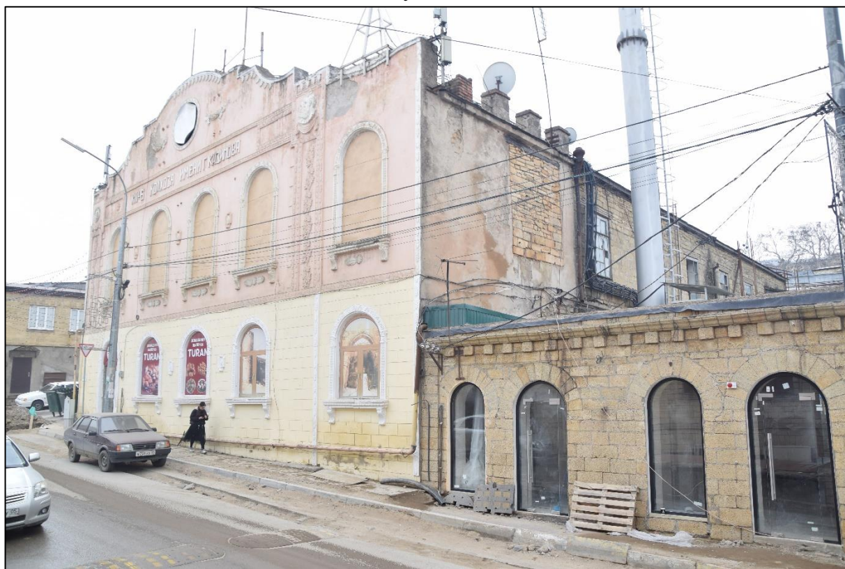
Фото 18. Общий вид здания со стороны ул. Крупской, угол главного фасада и бокового торцевого фасада.
