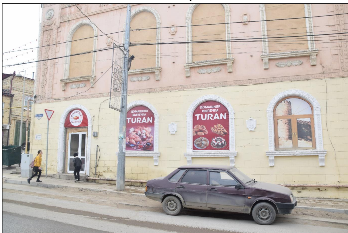
Фото 16. Главный фасад здания, первый этаж с главным входом в здание.
