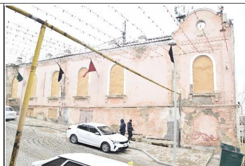
Боковой фасад здания по ул. 6-й Магал
