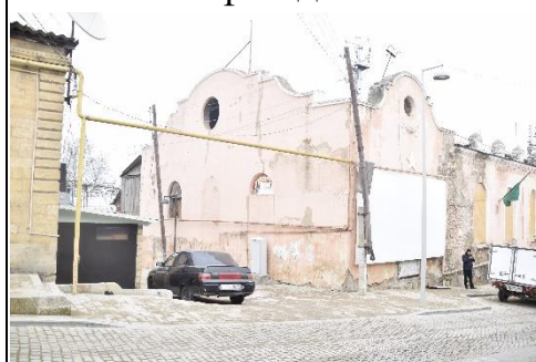
Оконные фасады дворового фасада и бокового
