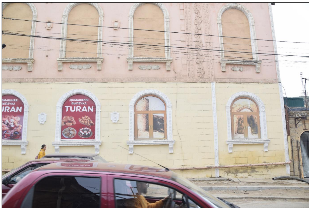
Фото 17. Первый этаж здания, оконные проемы по этажам, руст по первому этажу здания.
