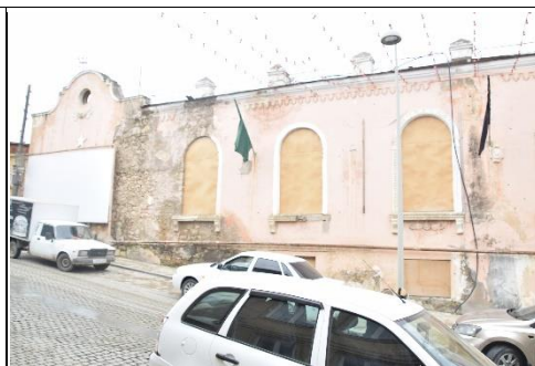
Оконные проемы бокового фасада здания
