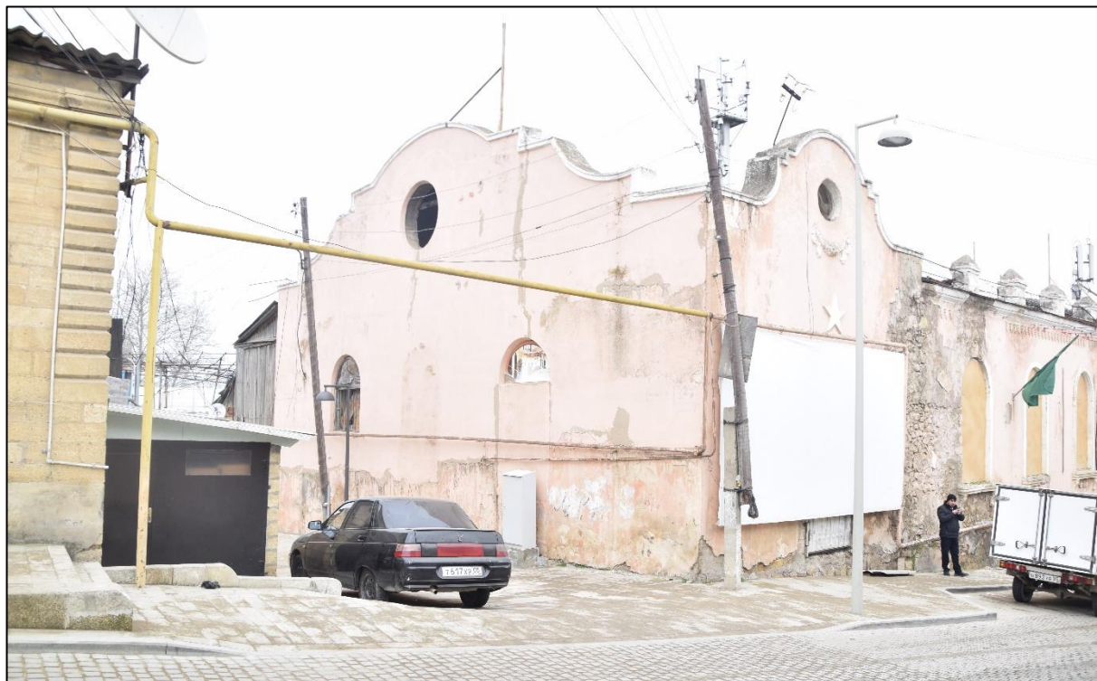
Фото 1. Угол здания по ул. 6-й Магал, дворовой фасад с массивным аттиком и боковой фасад.
