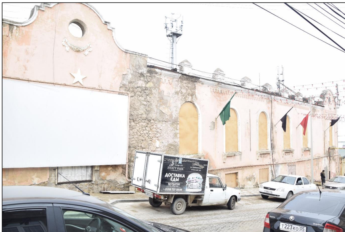
Фото 5. Общий вид фасада по ул. 6-й Магал, оконные проемы здания, столбики парапета с заполнением.
