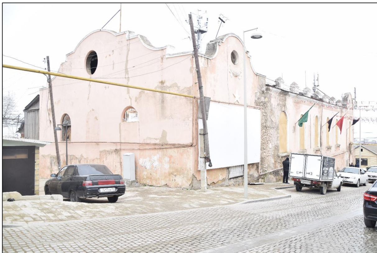
Фото 3. Общий вид угла здания по ул. 6-й Магал, рельеф улицы, отражающийся на этажности здания.
