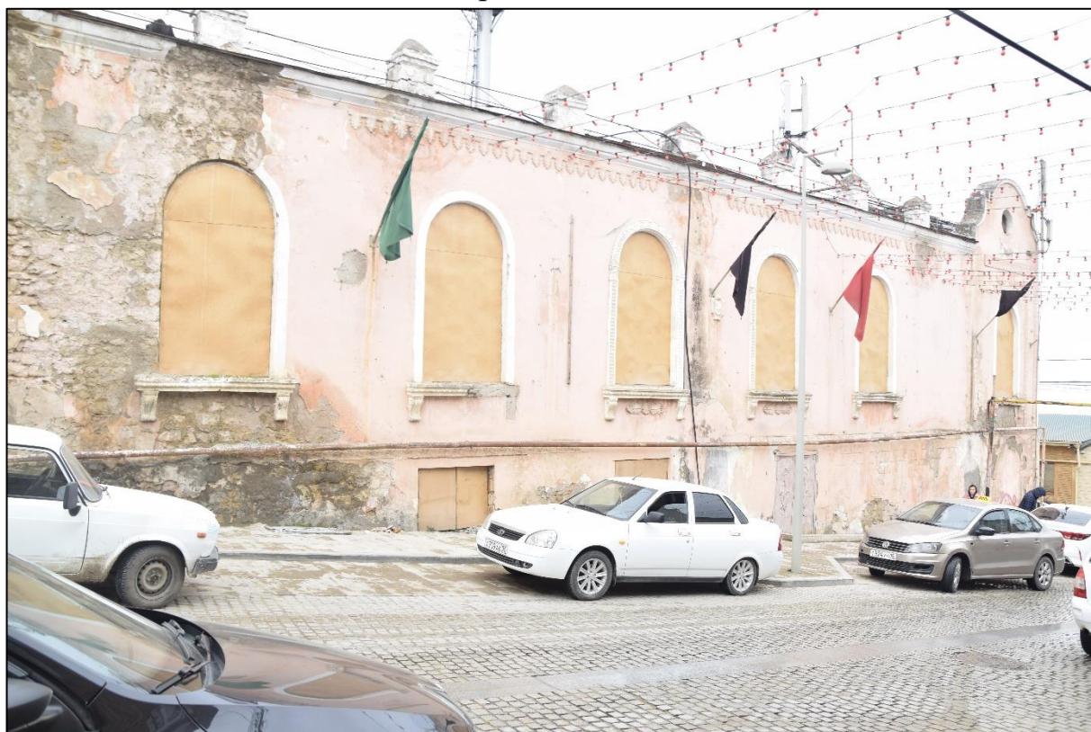
Фото 6. Оконные проемы второго этажа бокового фасада здания.
