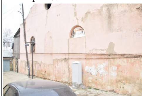
Оконные проемы дворового фасада
