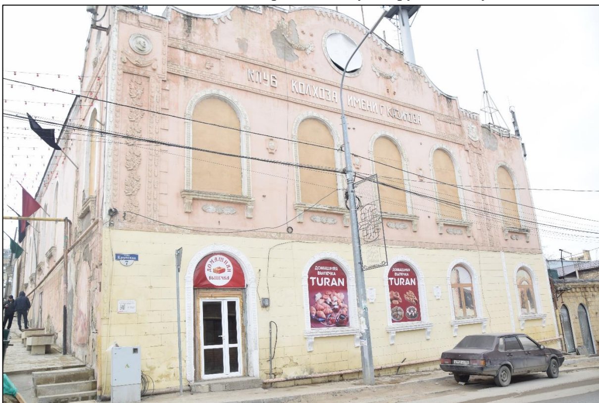
Фото 12. Главный фасад здания по ул. Крупской.
