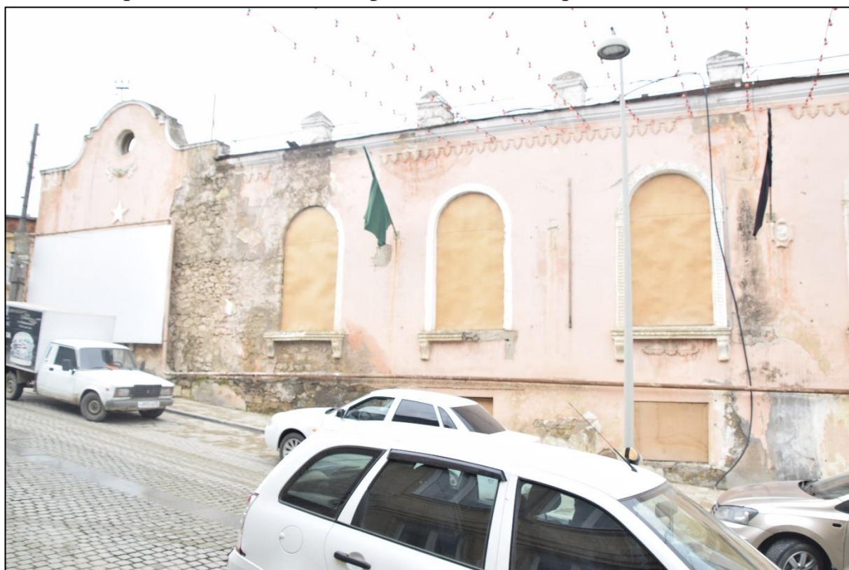
Фото 8. Правая часть бокового фасада здания, переход здания в один этаж.
