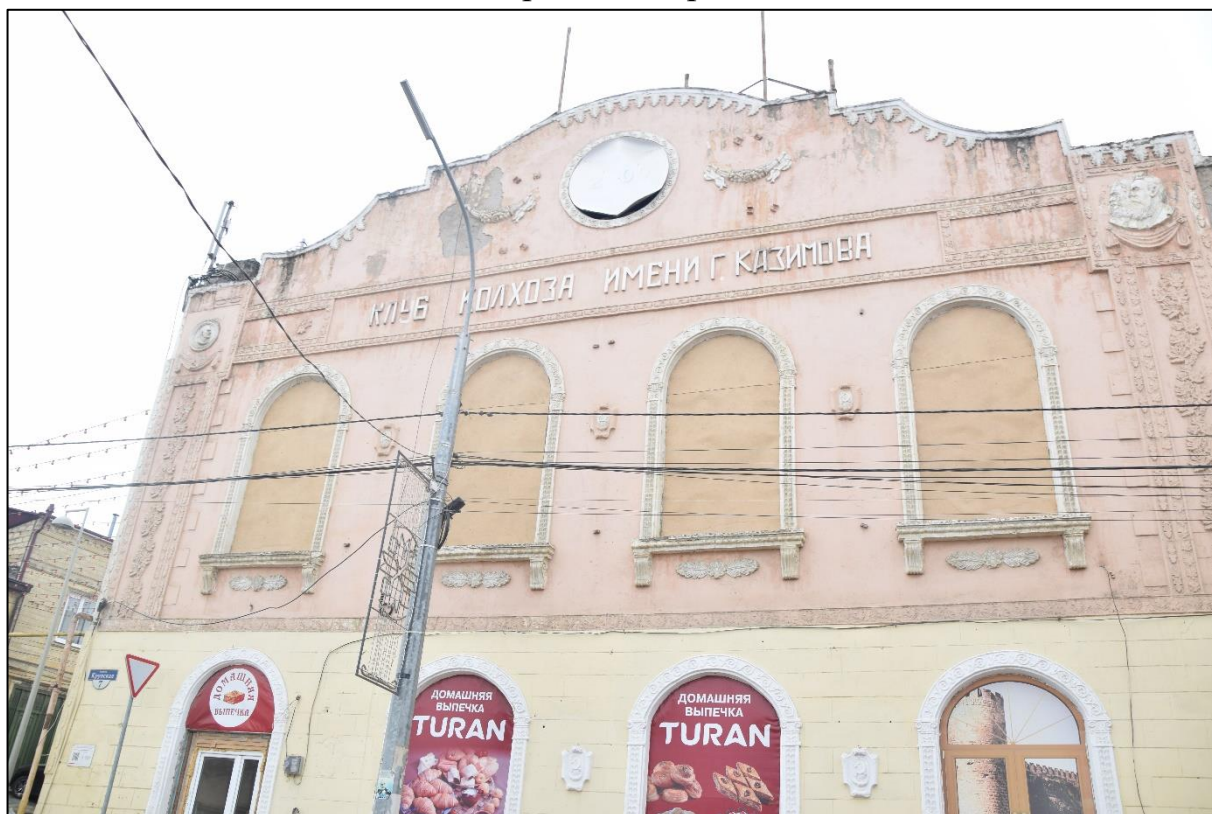
Фото 14. Архитектурно-художественные элементы фасада в простенках и над проемом: табличка и розетки.
