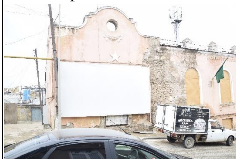
Люкарна аттика бокового фасада
