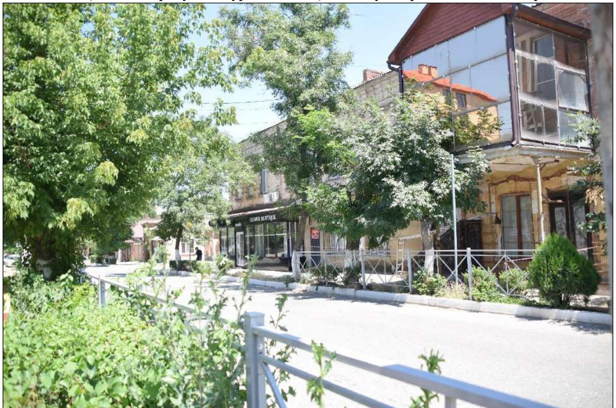
Т.ф. 3.6.3 Исторически ценный градоформирующий объект. Жилой дом (г. Хасавюрт, ул. Тотурбиева, 105). Вид с ул. Ирчи Казака, с северо-востока.
