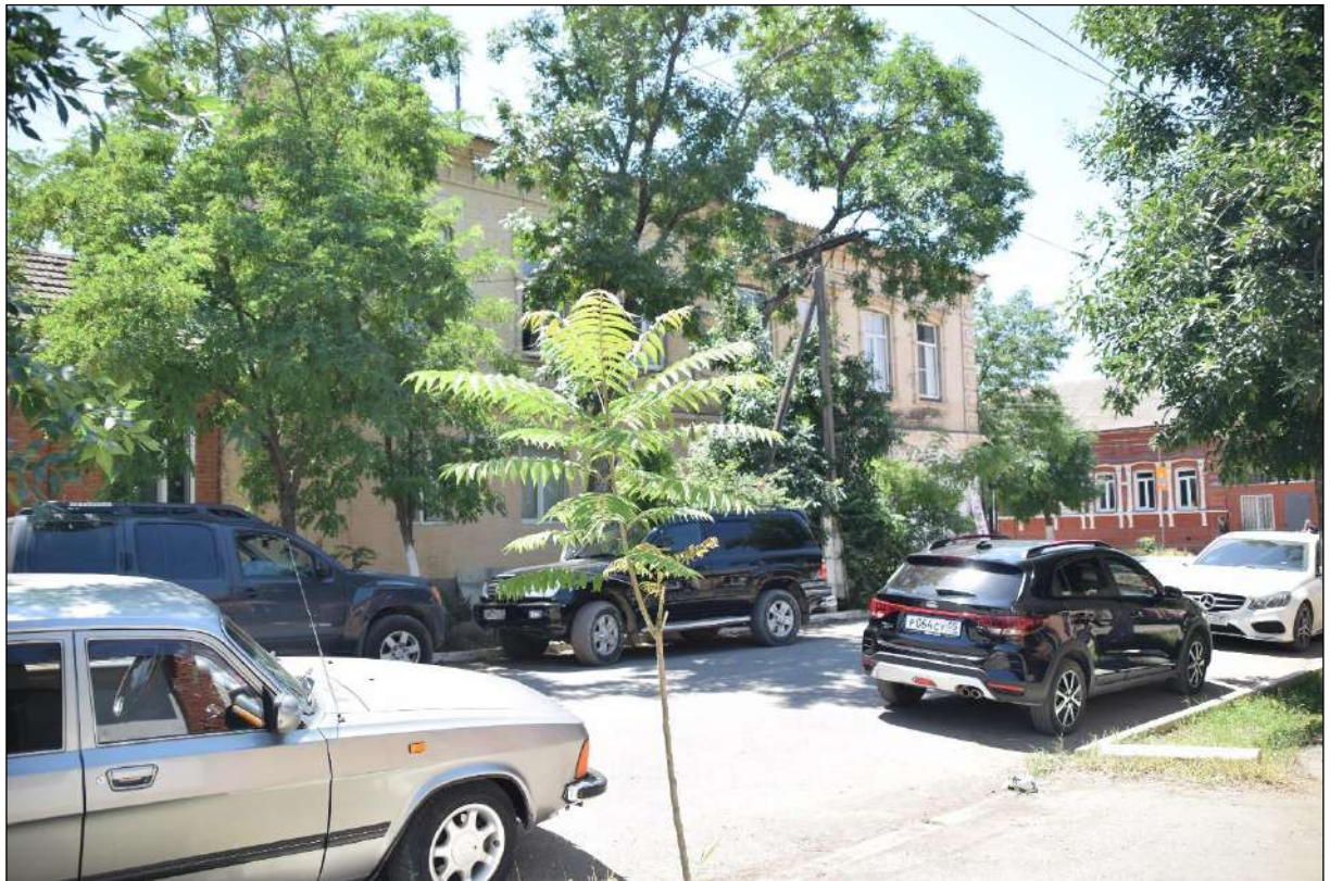
Т.ф. 3.6.2 Исторически ценный градоформирующий объект. Жилой дом (г. Хасавюрт, ул. Тотурбиева, 105). Вид с ул. Ирчи Казака, с северо-востока.
