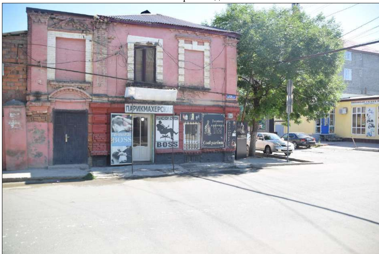
Т.ф. 3.1.2 Исторически ценный градоформирующий объект. Жилой дом (г. Хасавюрт, ул. Мусаева, 68). Вид с ул. Бараненко, с юго-запада.
