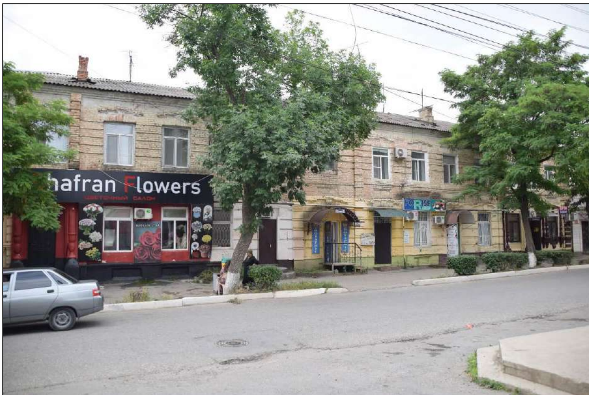
Т.ф. 3.8.2 Исторически ценный градоформирующий объект. Жилой дом (г. Хасавюрт, ул. Тотурбиева, 99). Вид с ул. Тотурбиева, с запада.
