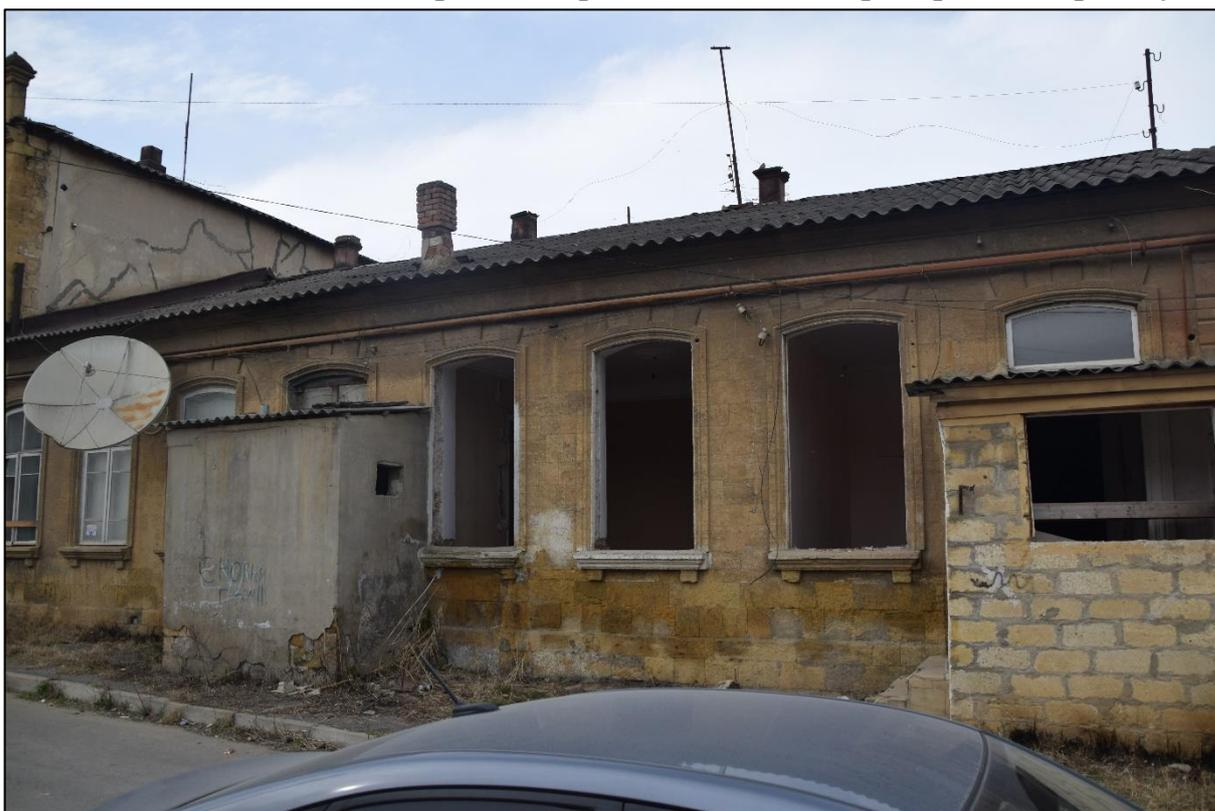
**Фото 10.** Оконные проемы без заполнения справа от сквозного проезда здания.
