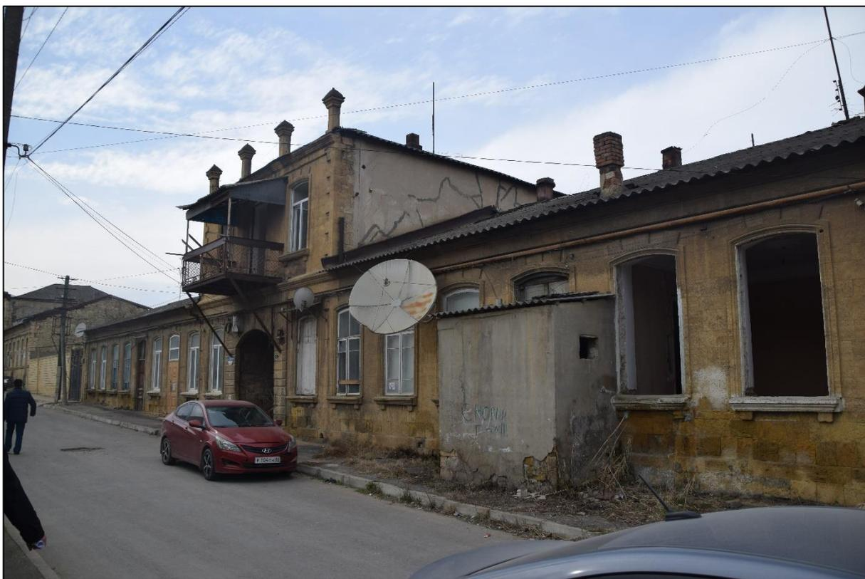
**Фото 11.** Вид на оконные и дверные проемы первого этажа здания, поздние пристройки к фасаду справа от проезда.
