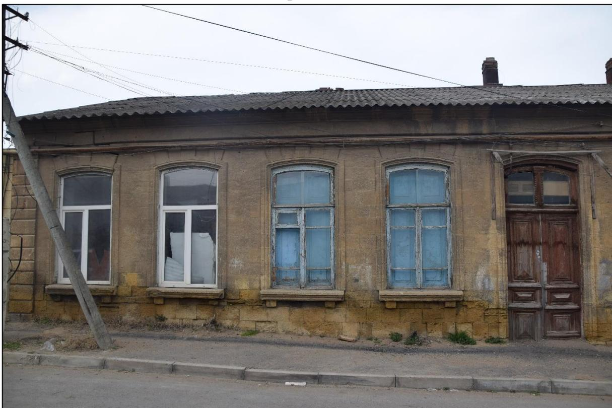
**Фото 4.** Пять световых осей по левую сторону от сквозного проезда здания, дверной проем с историческим деревянным заполнением.
