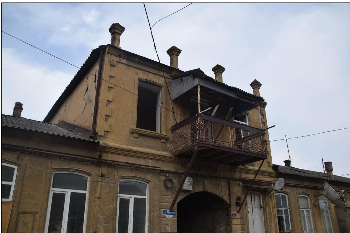
**Фото 6.** Вид на мезонин здания в три световых оси, навершия-колонны, венчающие мезонин.
