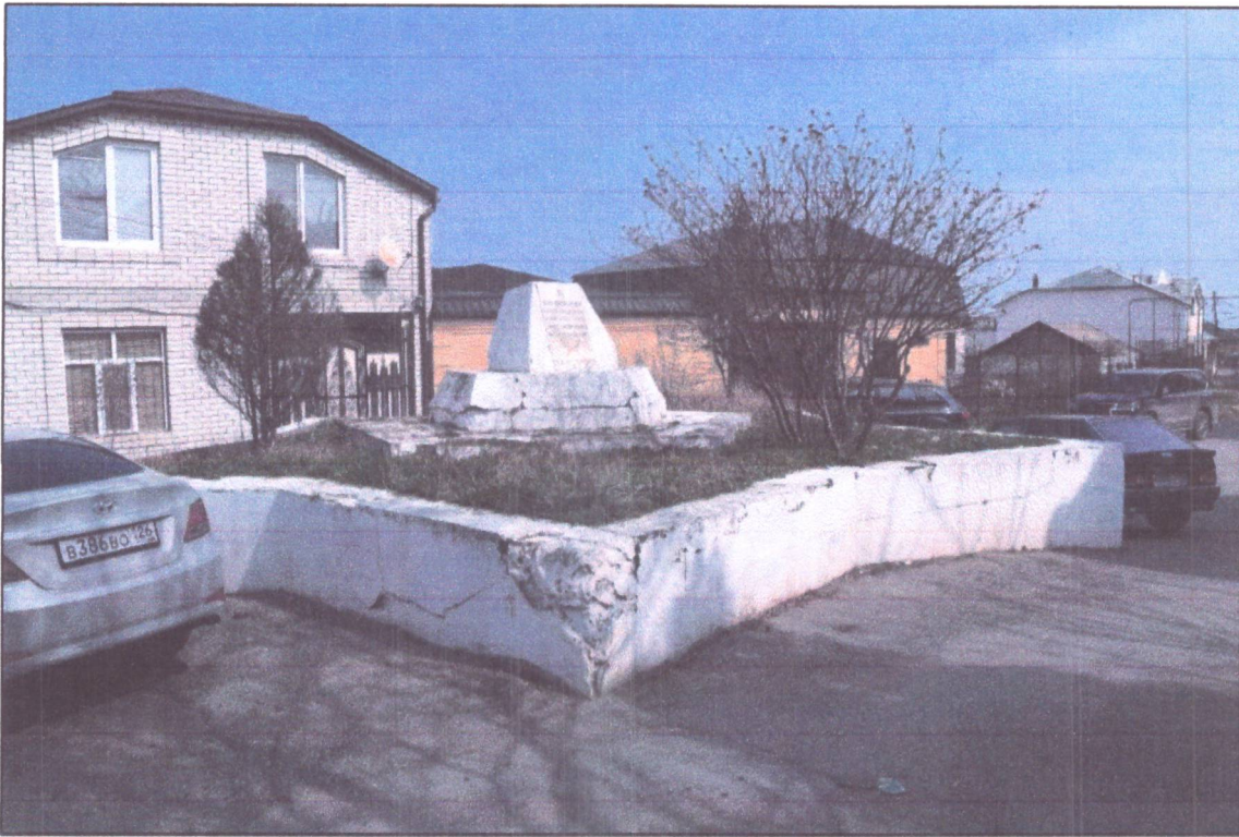
Т.ф.1. Общий вид с западной стороны.
