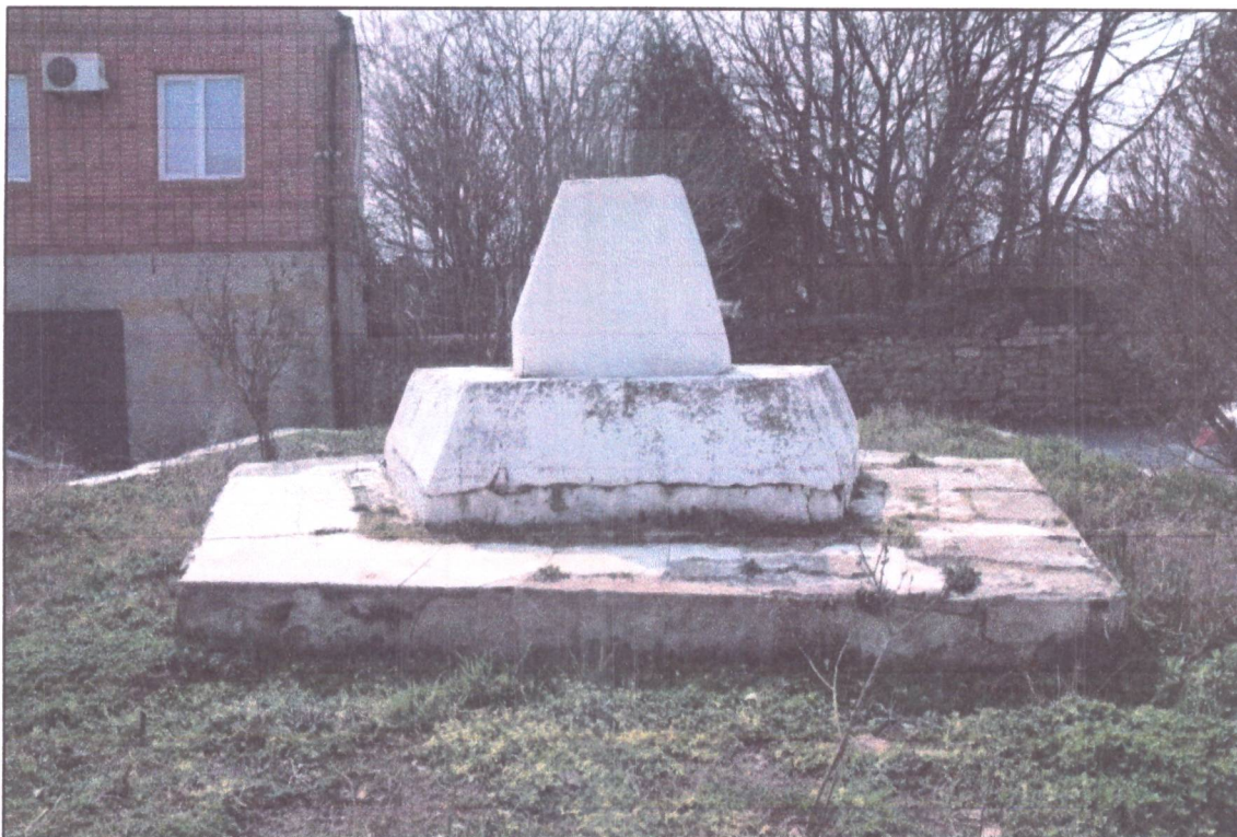
Т.ф.5. Вид с северо-восточной стороны.
