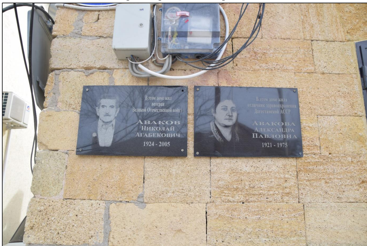
Фото 8. Вид на мемориальные доски установленные на дворовом фасаде здания.
