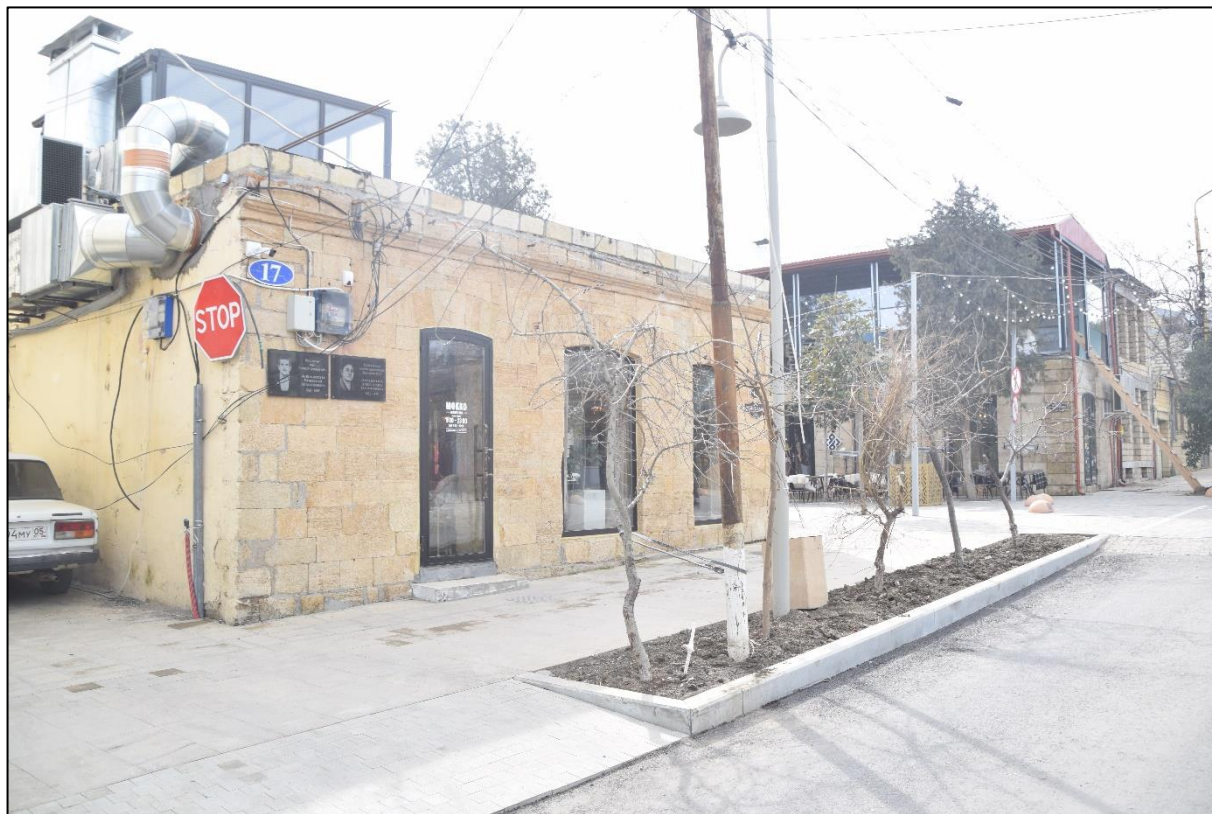
Фото 1. Общий вид здания с севера с улицы Канделаки.
