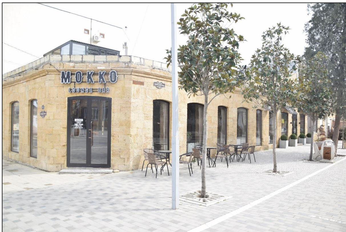
Фото 4. Вид на западный фасады здания по ул. Кази-Бека, главный и дополнительные входы в здание.
