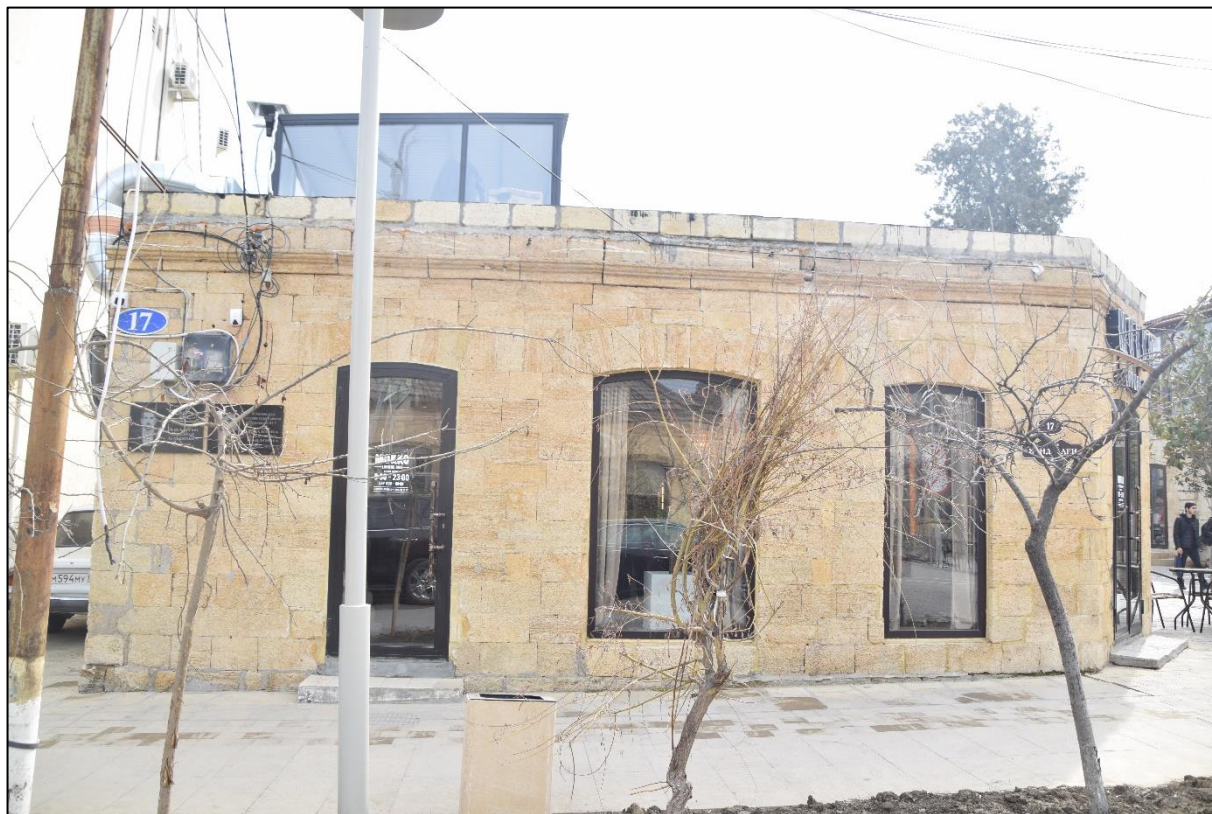
Фото 2. Вид северного фасада здания по ул. Канделаки.
