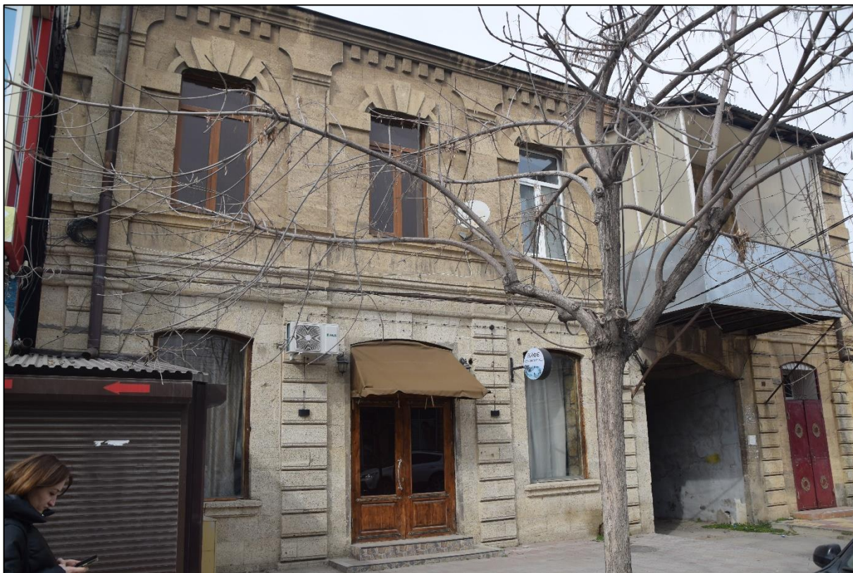
Фото 3. Архитектурно-художественные элементы здания, карниз с сухариками, молдинг, межэтажный пояс, пилястры с рустом.
