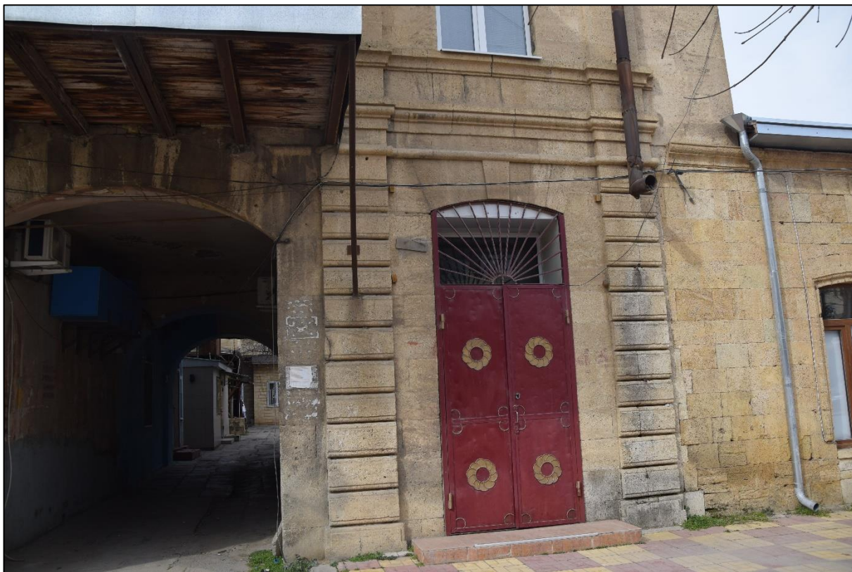
Фото 7. Первый этаж здания с рустом по пилястрам, главный вход в первый этаж здания.
