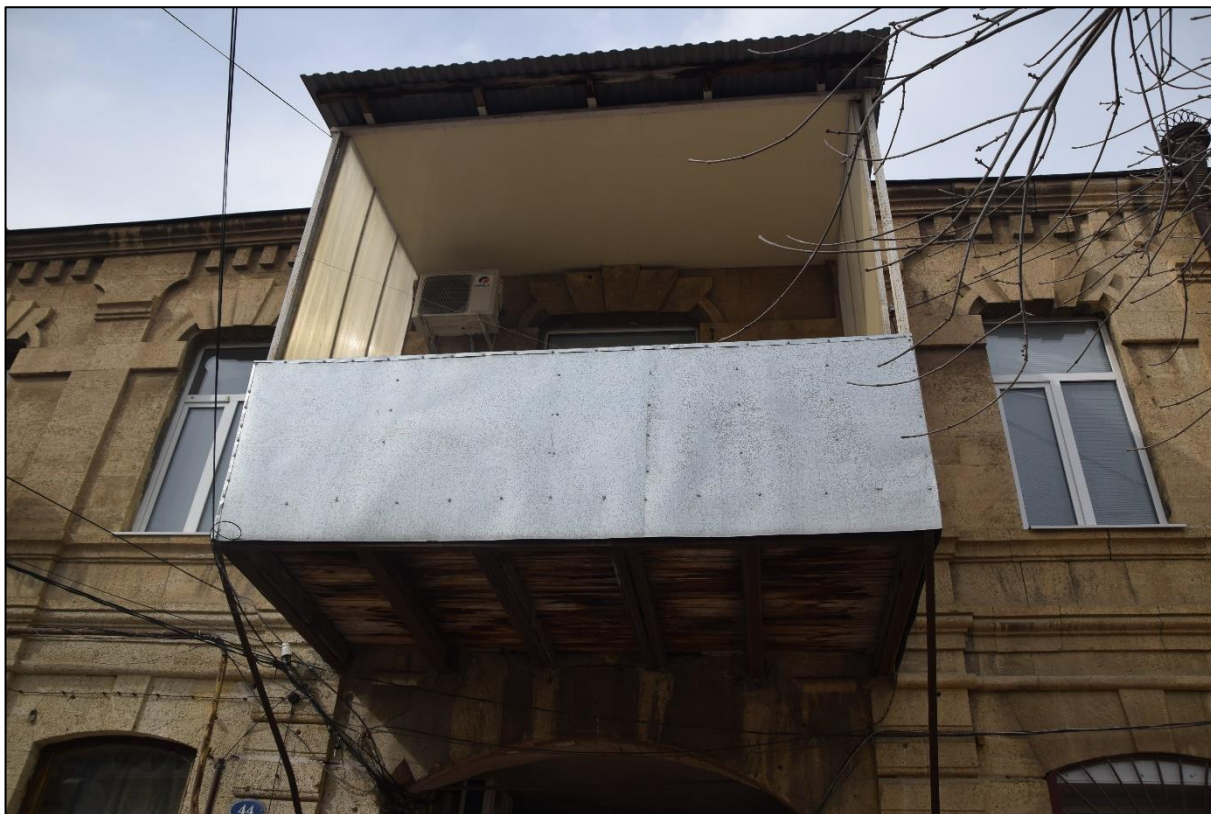
Фото 9. Вид на поздний балкон здания над сквозным проездом здания.
