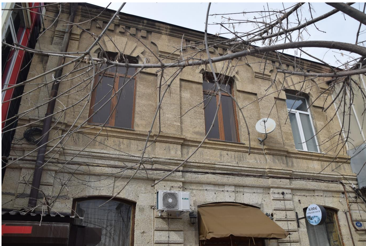
Фото 5. Второй этаж здания с архитектурно-художественными элементами, пилястры по второму этажу, оконные проемы второго этажа с сандриками.
