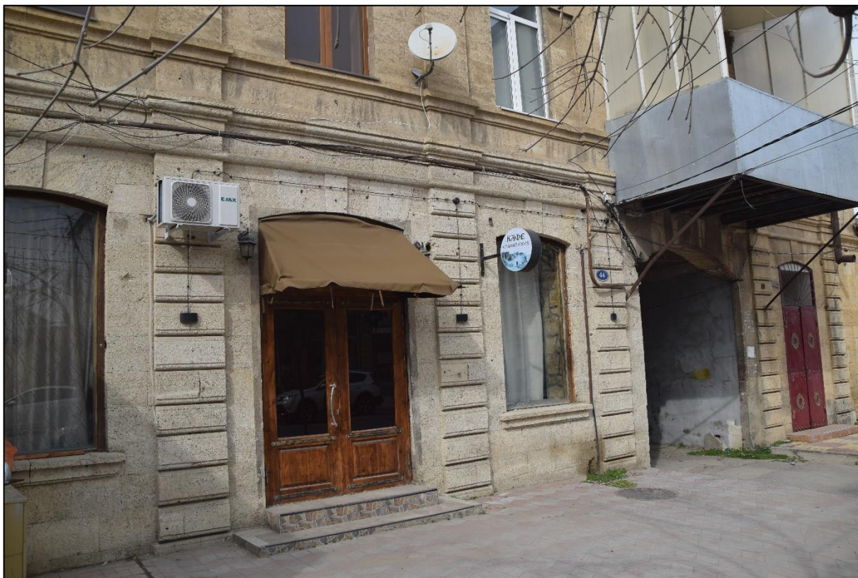
Фото 4. Первый этаж здания с рустом по пилястрам, оконные и дверные проемы первого этажа.
