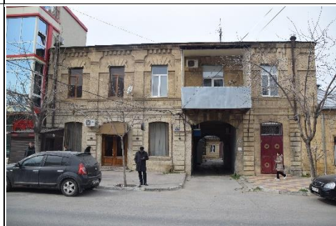
Общий вид здания (главный фасад)
