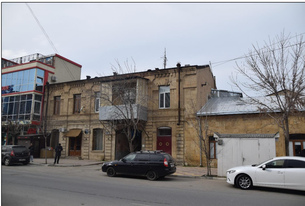
Фото 2. Общий вид здания по ул. Ленина, главный фасад и часть торца здания.
