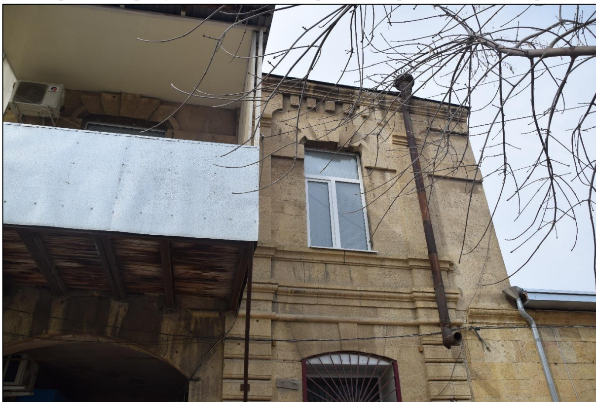
Фото 6. Второй этаж здания с архитектурно-художественными элементами, пилястры по второму этажу, оконный проем над главным входом в здание.
