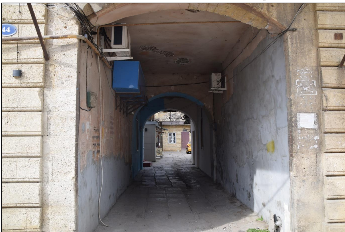
Фото 10. Сквозной проезд здания ведущий в дворовой фасад здания.
