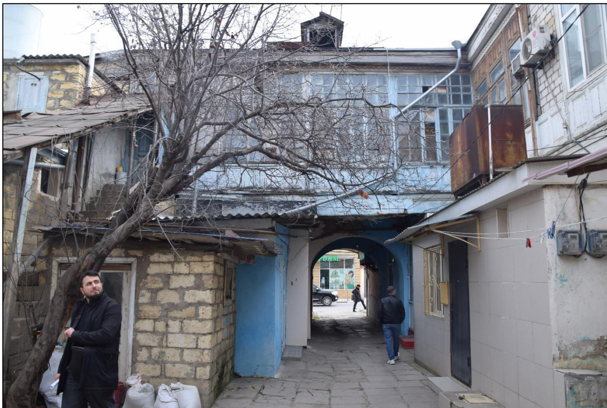
Фото 11. Вид здания со стороны дворового фасада, сквозной проезд, заполнение оконных проемов.
