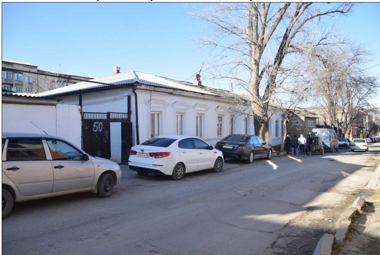
Исторически ценный градоформирующий объект (г. Буйнакск, ул. Шихсаидова, 50).
