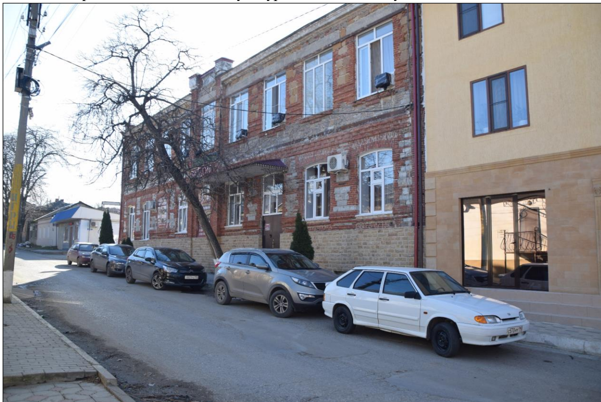
Исторически ценный градоформирующий объект (г. Буйнакск, ул. Шихсаидова, 46).
