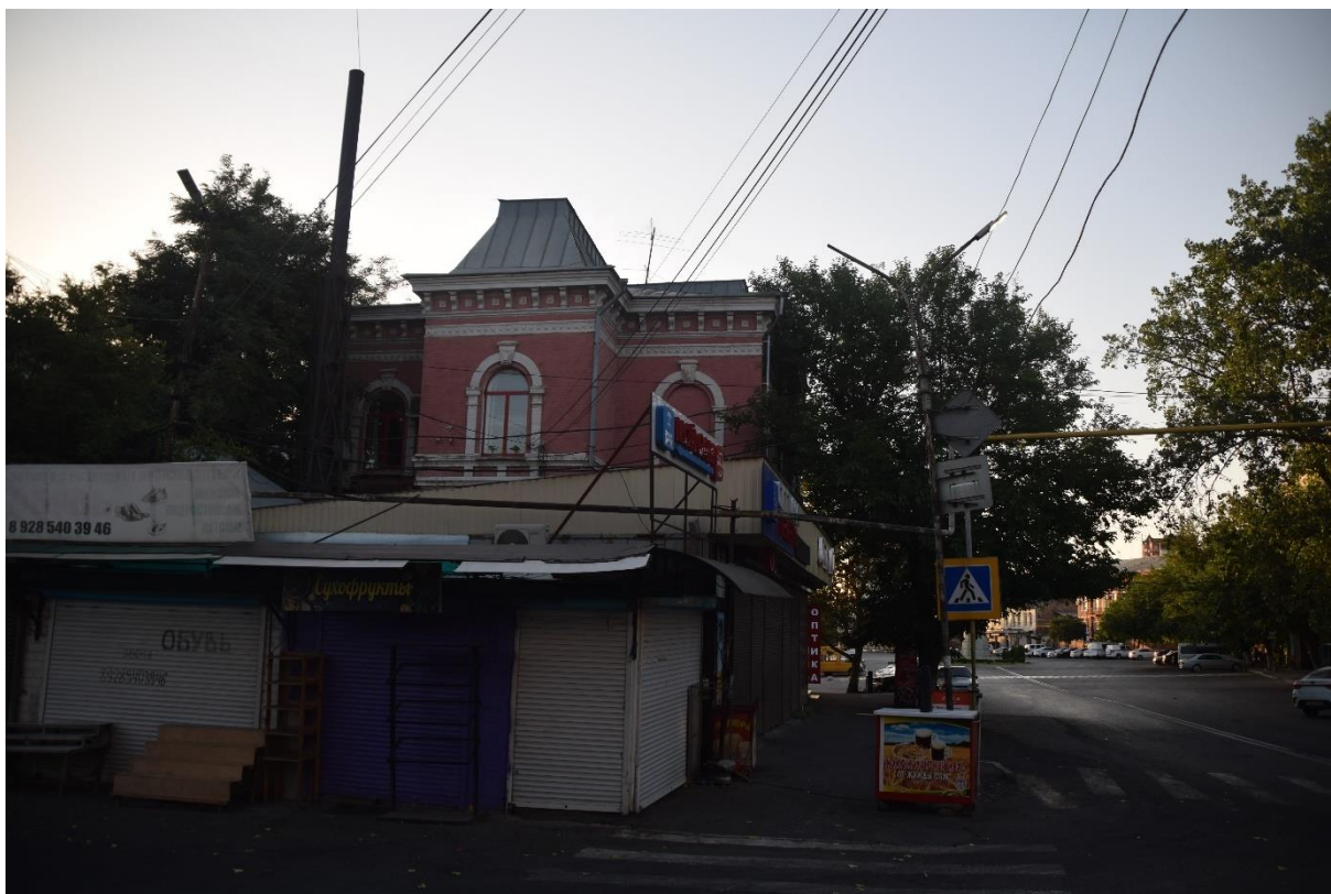
Фото 7. Вид на западный фасад здания, с ул. Эмирова, ризалит здания
