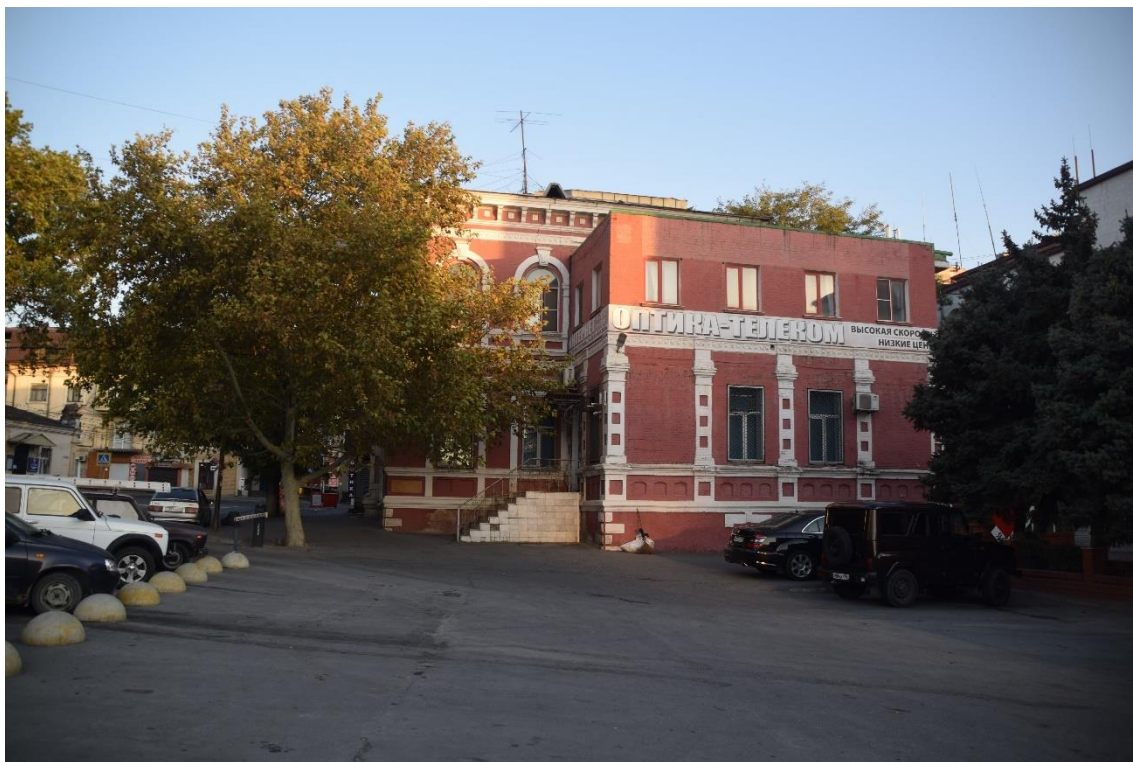
Фото 1. Общий вид на исследуемый объект с Привокзальной площади, пристройки
