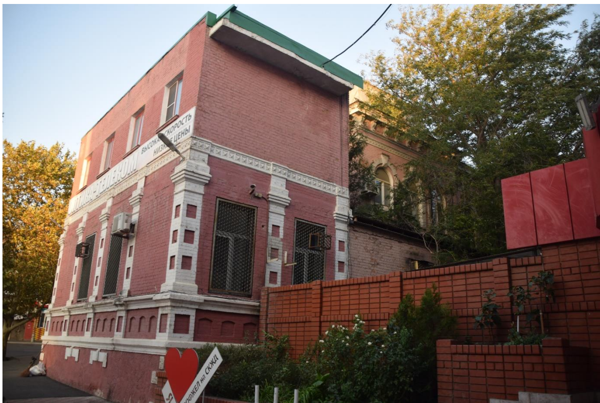
Фото 3. Вид на исследуемый объект с северной стороны, дворовая часть территории
