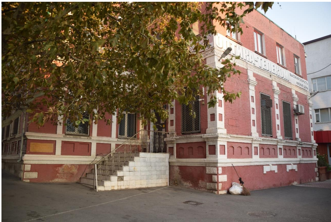
Фото 2. Общий вид на исследуемый объект с Привокзальной площади, пристройки
