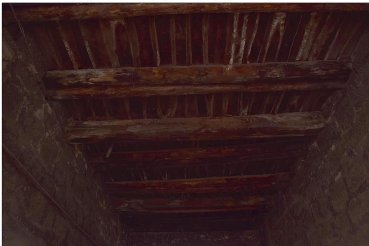
**Фото 8.** Деревянные балки перекрытия проезда, продольные и поперечные балки перекрытия.
