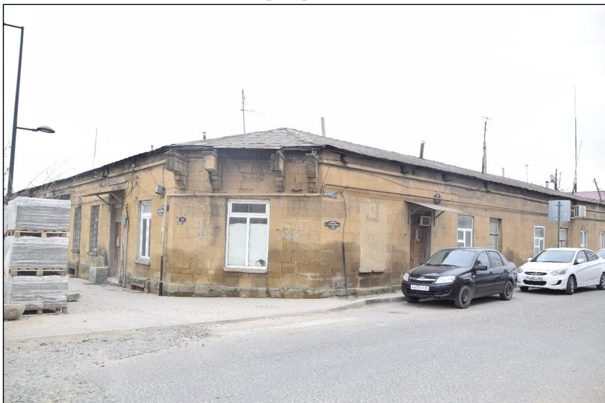
**Фото 14.** Вид на угловой фасад здания, спаренные кронштейны на углу здания (венчающий элемент угла, фронтон - утрачен).
