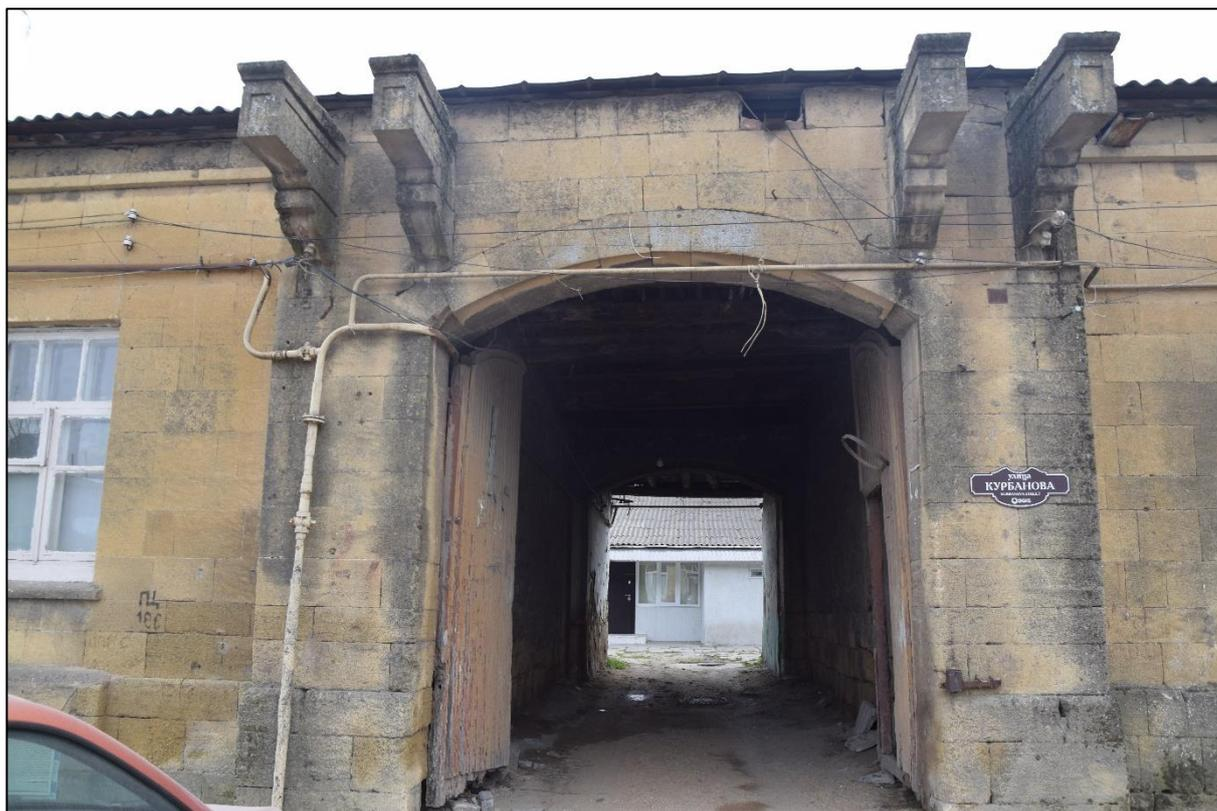
**Фото 3.** Вид на сквозной проезд через арку, характерный архитектурный элемент в виде спаренных кронштейнов.
