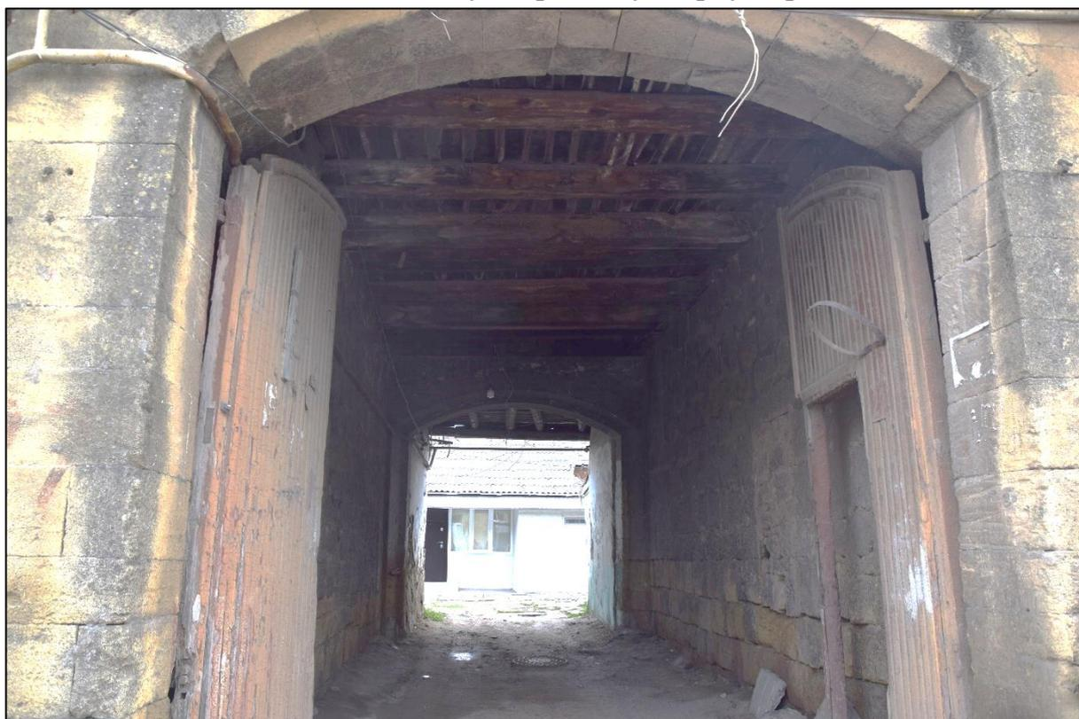
**Фото 6.** Внутренняя часть сквозного проезда через арку, элементы перекрытия проезда.
