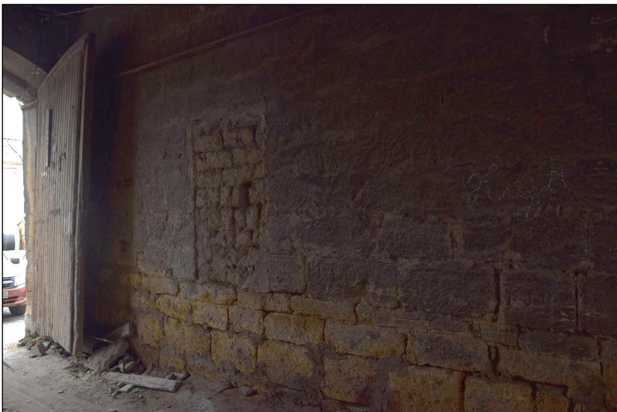
**Фото 11.** Заложенный проем в проезде здания за аркой, слева от арки.
