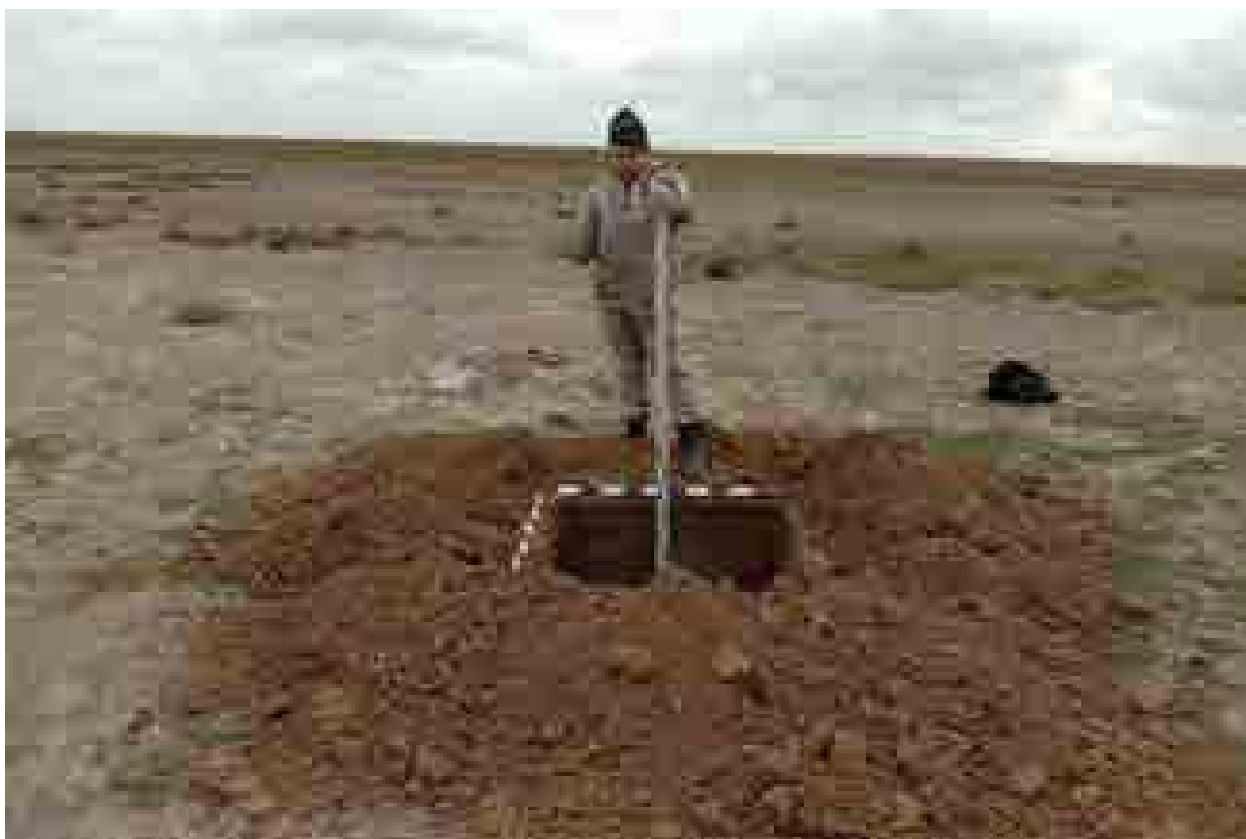
Илл. 194. Республика Дагестан, Ногайский район. Земельный участок под строительство «Ногайской СЭС». Шурф 38. Общий вид с С.
