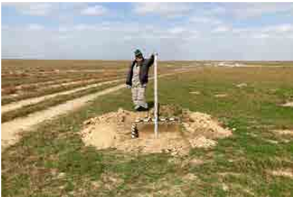
Илл. 36 . Республика Дагестан, Ногайский район. Земельный участок под строительство «Ногайской СЭС». Шурф 80. Общий вид с Ю.
