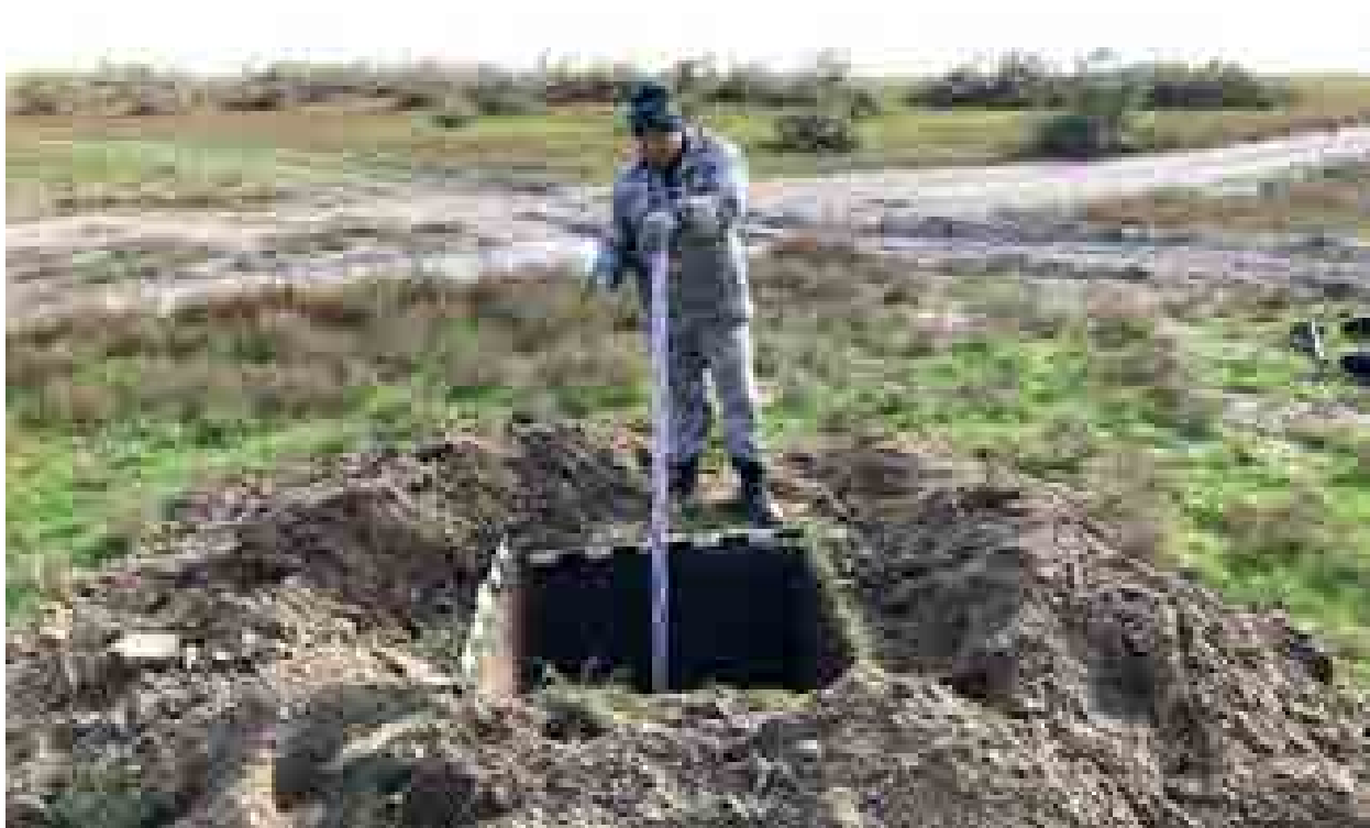
Илл. 4 6. Республика Дагестан, Ногайский район. Земельный участок под строительство «Ногайской СЭС». Шурф 96. Общий вид с С.
