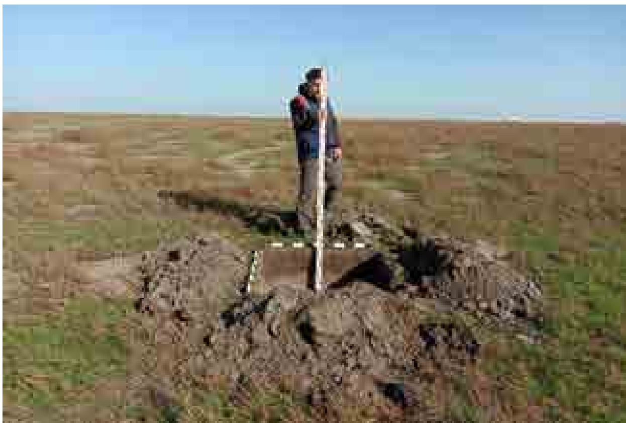
Илл. 314. Республика Дагестан, Ногайский район. Земельный участок под строительство «Ногайской СЭС». Шурф 68. Общий вид с Ю.
