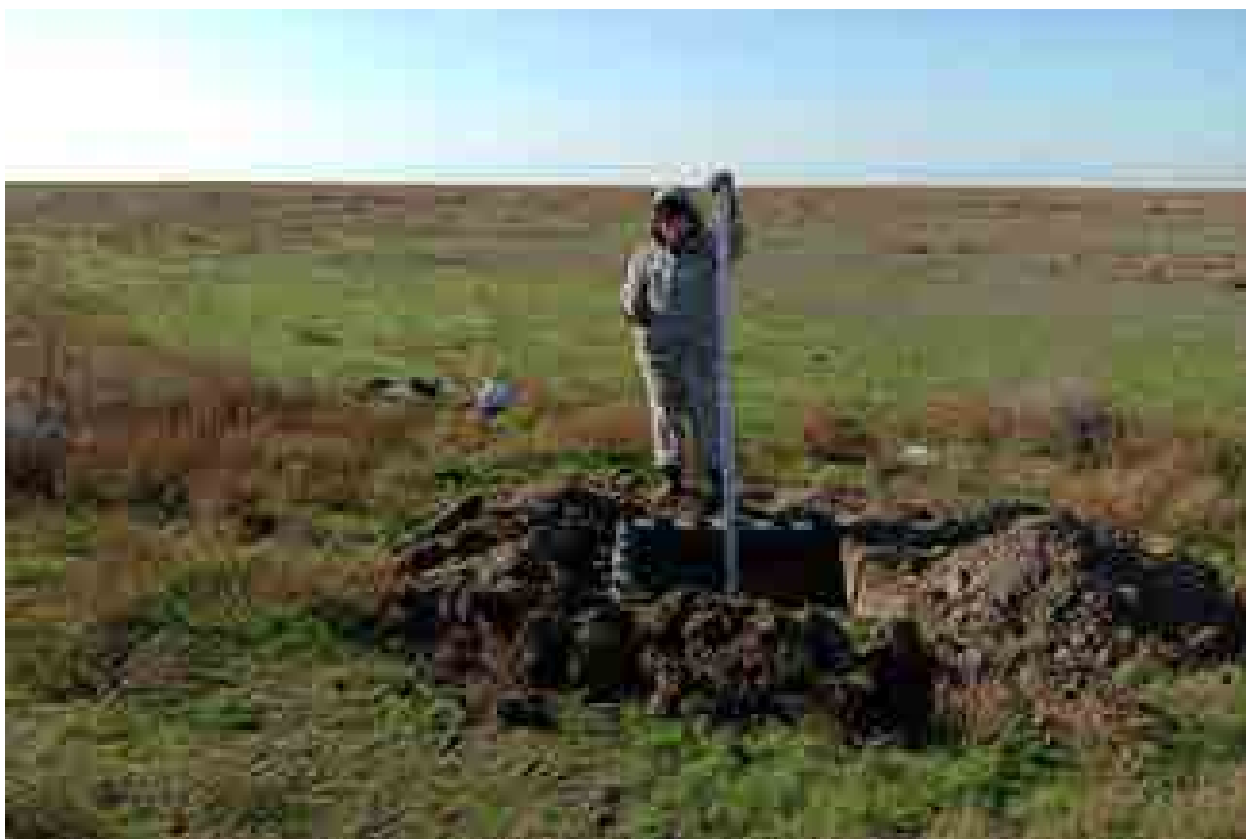
Илл. 446. Республика Дагестан, Ногайский район. Земельный участок под строительство «Ногайской СЭС». Шурф 101. Общий вид с С.
