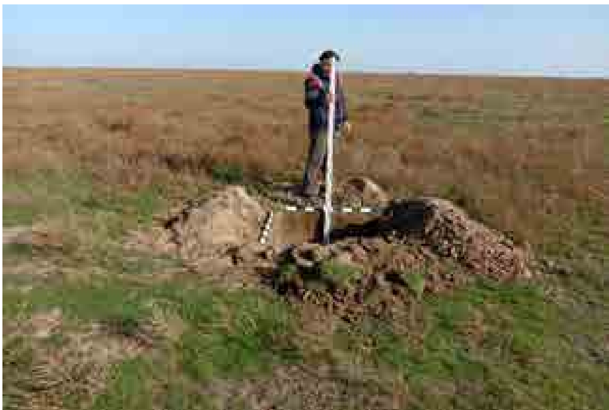
Илл. 310. Республика Дагестан, Ногайский район. Земельный участок под строительство «Ногайской СЭС». Шурф 67. Общий вид с Ю.
