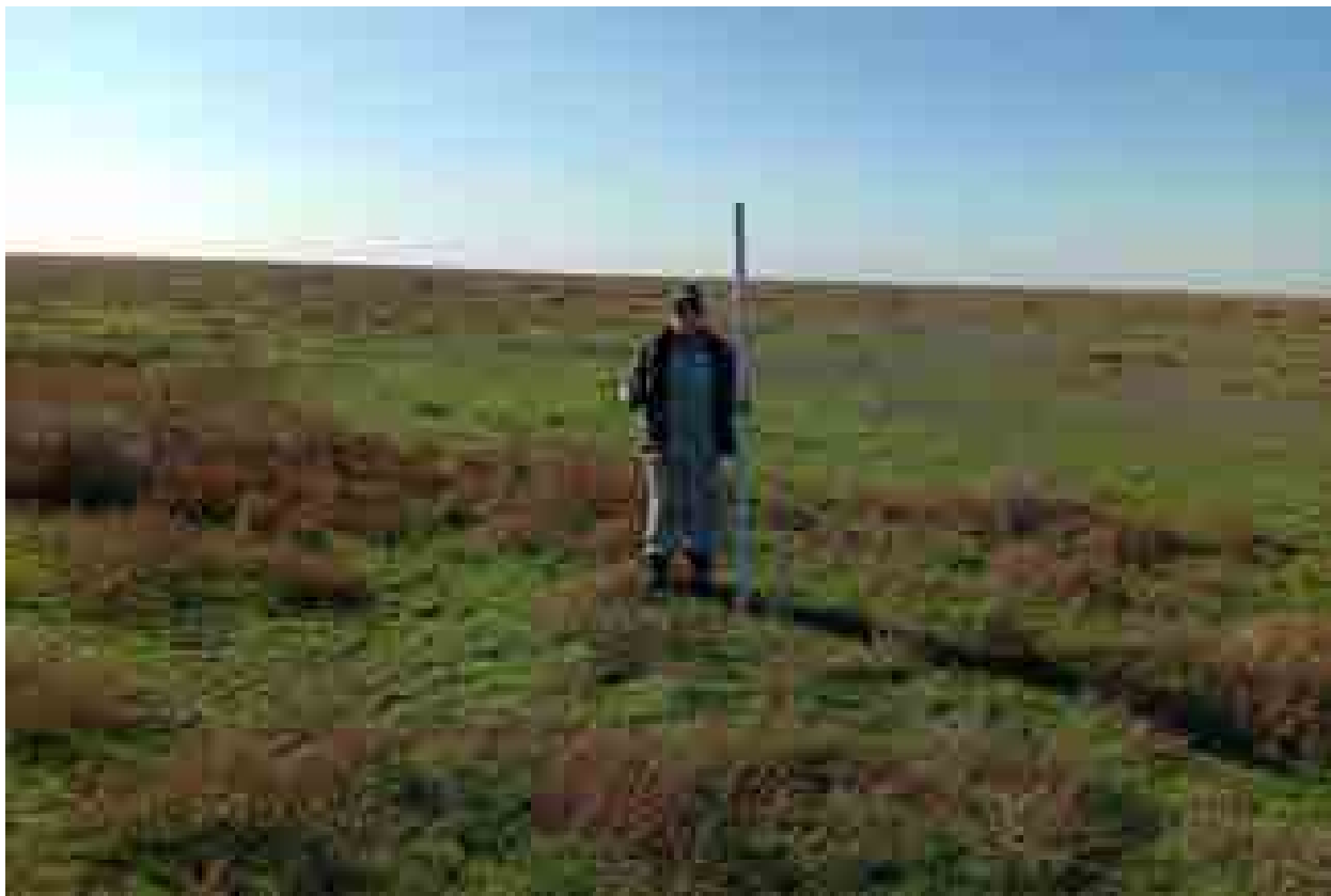
Илл. 445. Республика Дагестан, Ногайский район. Земельный участок под строительство «Ногайской СЭС». Шурф 101 до начала работ. Вид с С.
