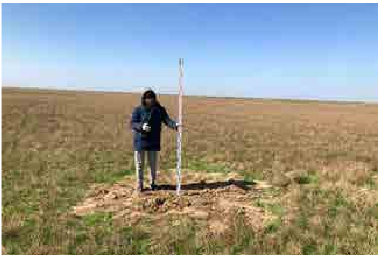
Илл. 604. Республика Дагестан, Ногайский район. Земельный участок под строительство «Ногайской СЭС». Шурф 140 после рекультивации. Общий вид с В.
