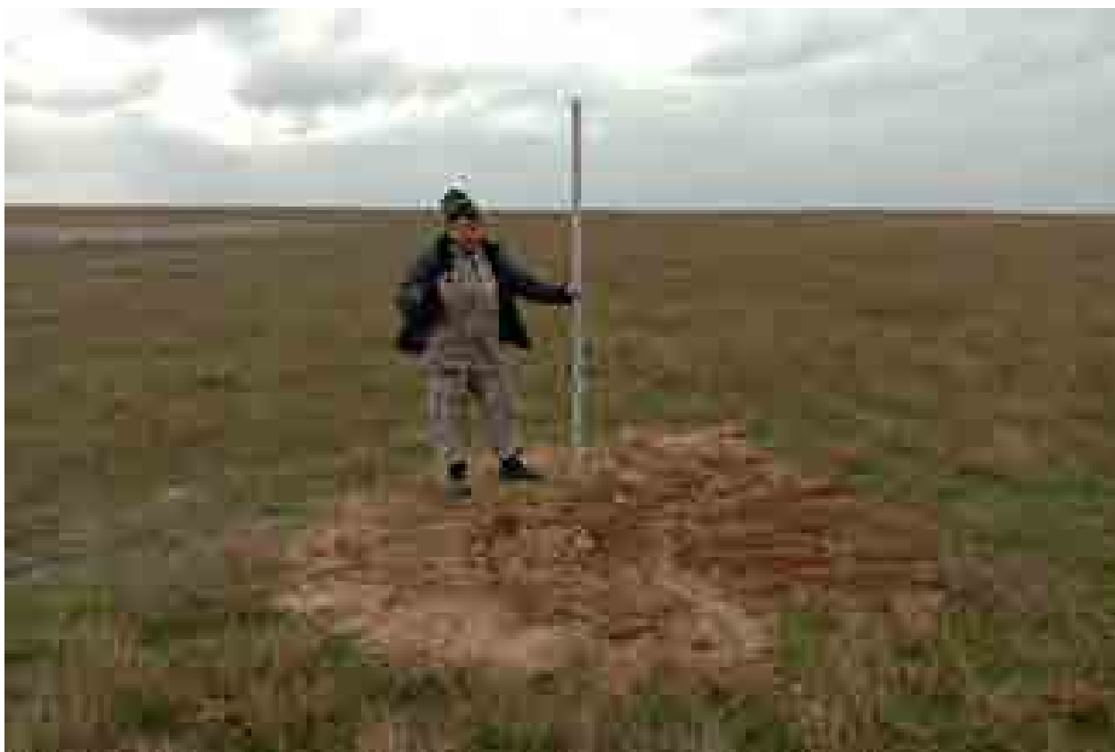
Илл. 19 . Республика Дагестан, Ногайский район. Земельный участок под строительство «Ногайской СЭС». Шурф 37 после рекультивации. Общий вид с В.
