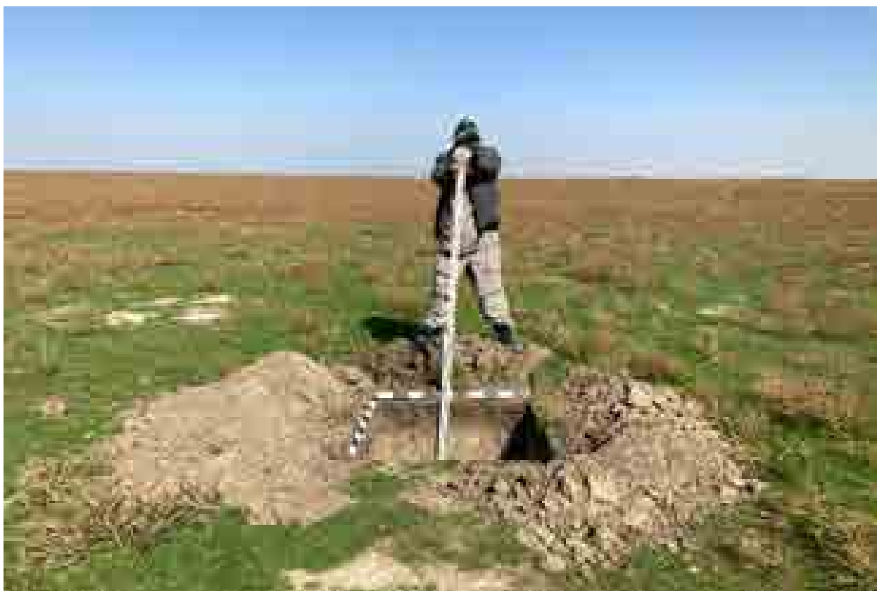
Илл. 350. Республика Дагестан, Ногайский район. Земельный участок под строительство «Ногайской СЭС». Шурф 77. Общий вид с Ю.
