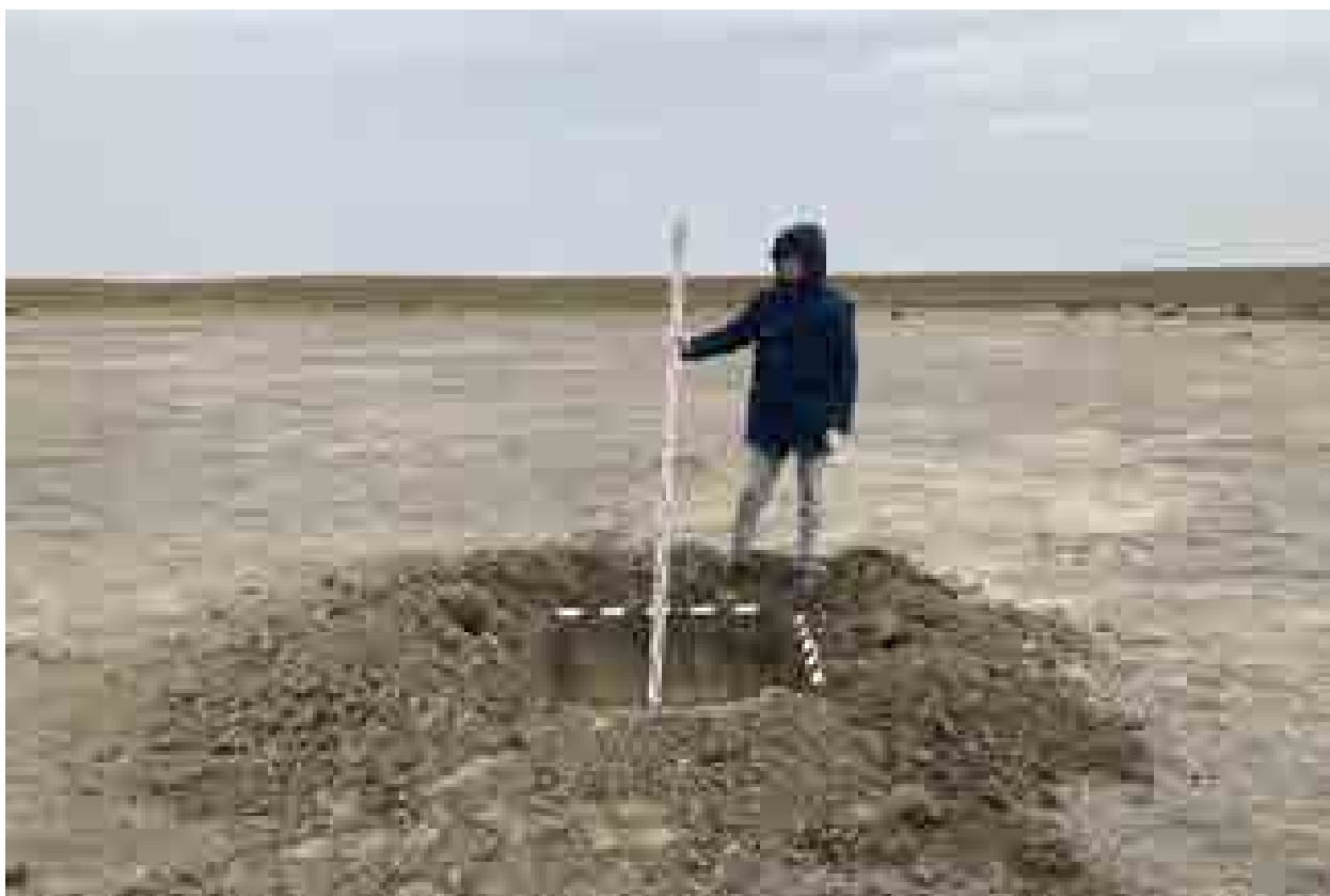
Илл. 158. Республика Дагестан, Ногайский район. Земельный участок под строительство «Ногайской СЭС». Шурф 29. Общий вид с Ю.
