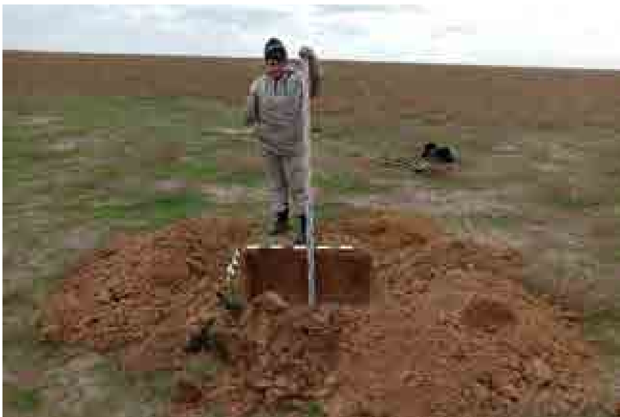
Илл. 8 . Республика Дагестан, Ногайский район. Земельный участок под строительство «Ногайской СЭС». Шурф 10. Общий вид с С.
