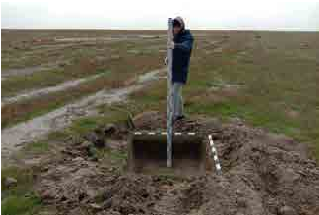
Илл. 38 . Республика Дагестан, Ногайский район. Земельный участок под строительство «Ногайской СЭС». Шурф 85. Общий вид с С.
