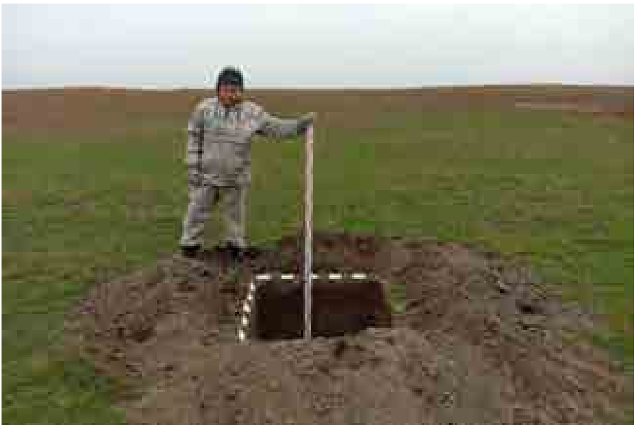
Илл. 6 . Республика Дагестан, Ногайский район. Земельный участок под строительство «Ногайской СЭС». Шурф 5. Общий вид с Ю.
