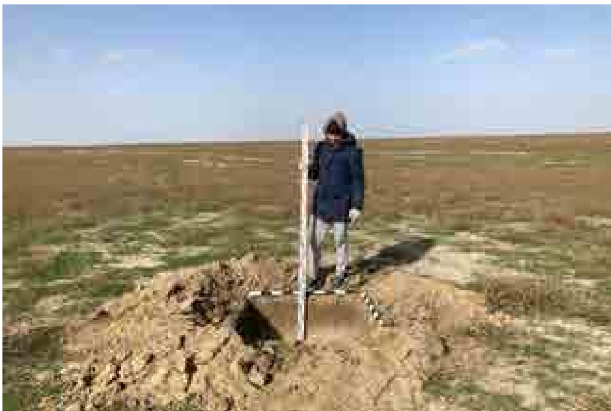
Илл. 618. Республика Дагестан, Ногайский район. Земельный участок под строительство «Ногайской СЭС». Шурф 144. Общий вид с Ю.
