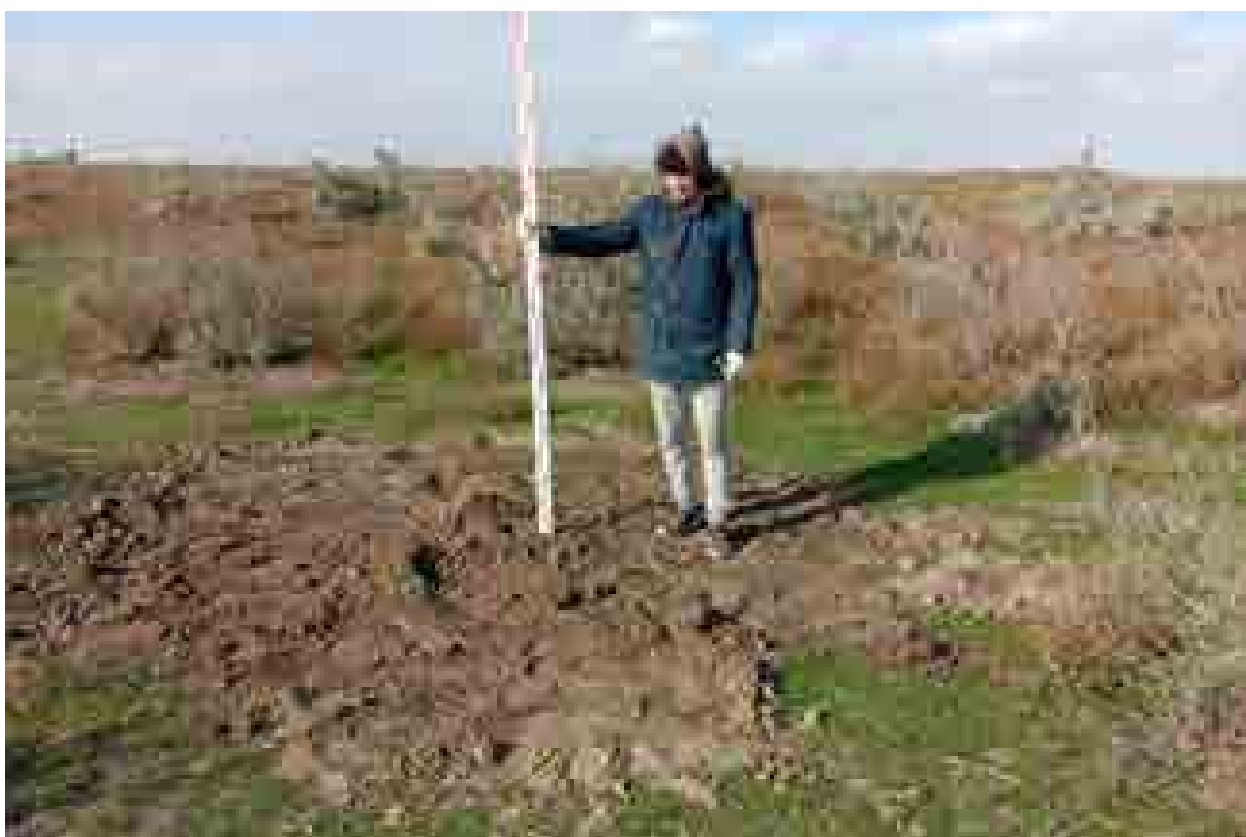
Илл. 368. Республика Дагестан, Ногайский район. Земельный участок под строительство «Ногайской СЭС». Шурф 81 после рекультивации. Общий вид с Ю.
