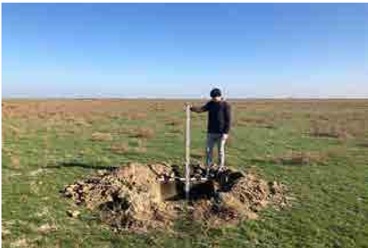
Илл. 474. Республика Дагестан, Ногайский район. Земельный участок под строительство «Ногайской СЭС». Шурф 108. Общий вид с Ю.
