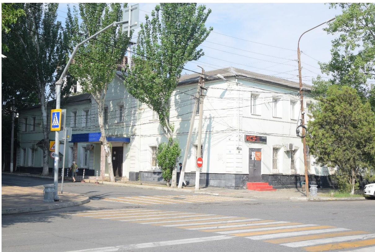
Фото 2. Угловой фасад исследуемого здания
