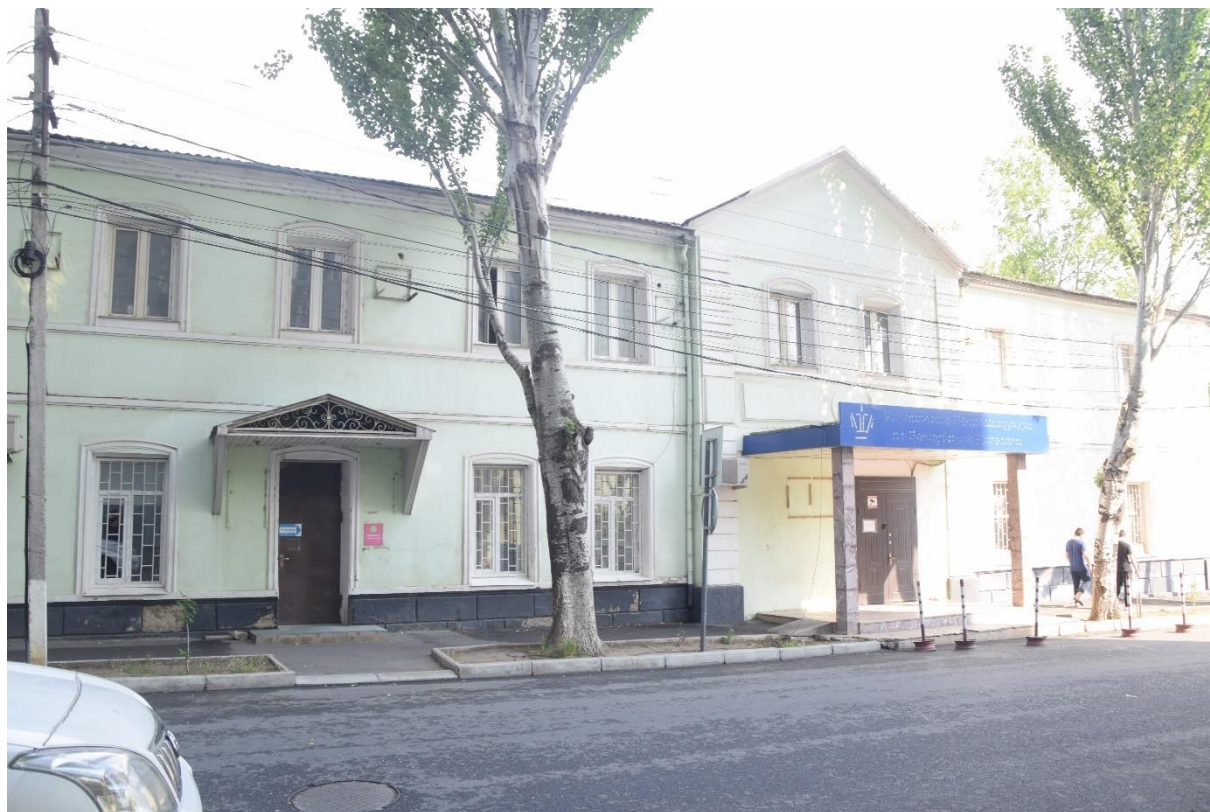
Фото 5. Фасад здания по ул. Стальского (восточный фасад застройки ул. Пушкина)
